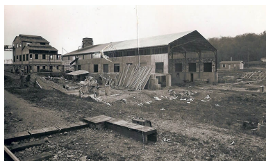
Vue d'ensemble depuis la gare. Phot. Emile Hérissé, Phot. Emile Hérissé IVR43_20077000454NUCA
