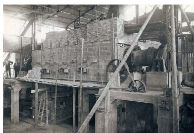
Bâtiment des fours. Four d'essai des schistes. Phot. Emile Hérissé, Phot. Emile Hérissé IVR43_20077000460NUCA
