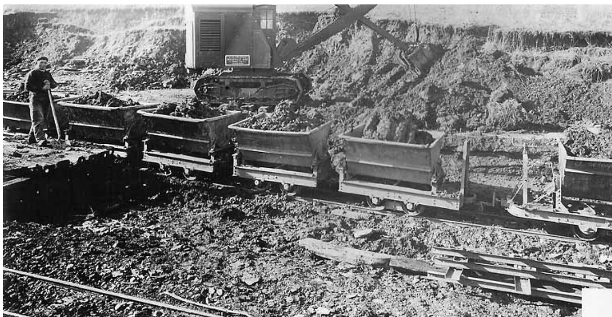
Chargement des wagonnets à la carrière.
