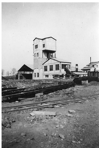
L'ensemble de concassage depuis le sud-ouest. Phot. Emile Hérissé, Phot. Emile Hérissé IVR43_20077000484NUCA
