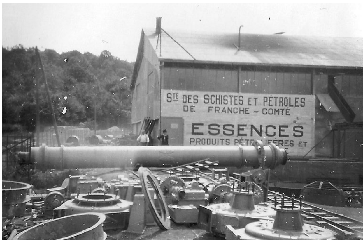
Déchargement du four.
