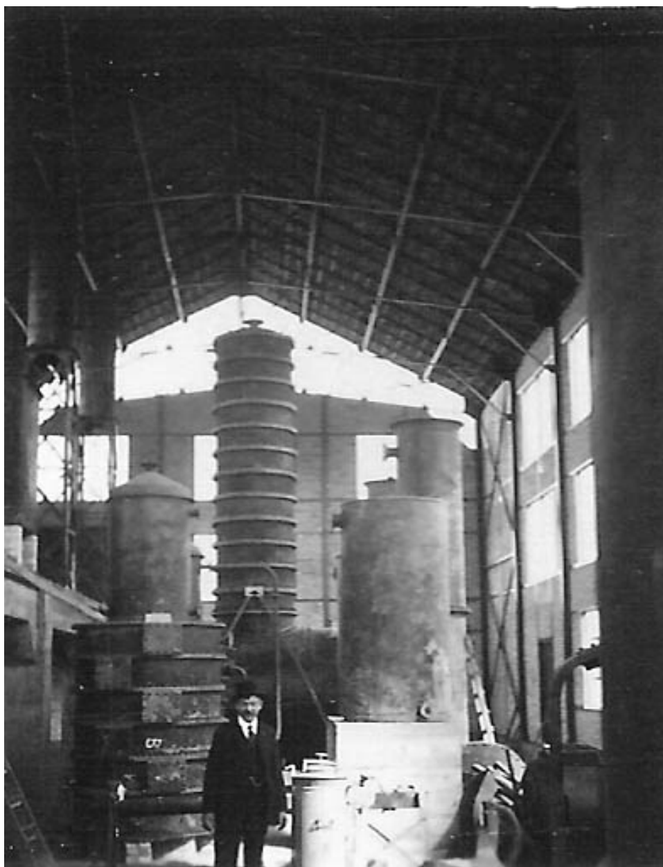
Vue intérieure de la raffinerie.
