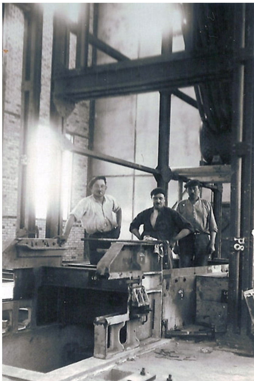
Bâtiment des fours. Montage des grilles automatiques.
