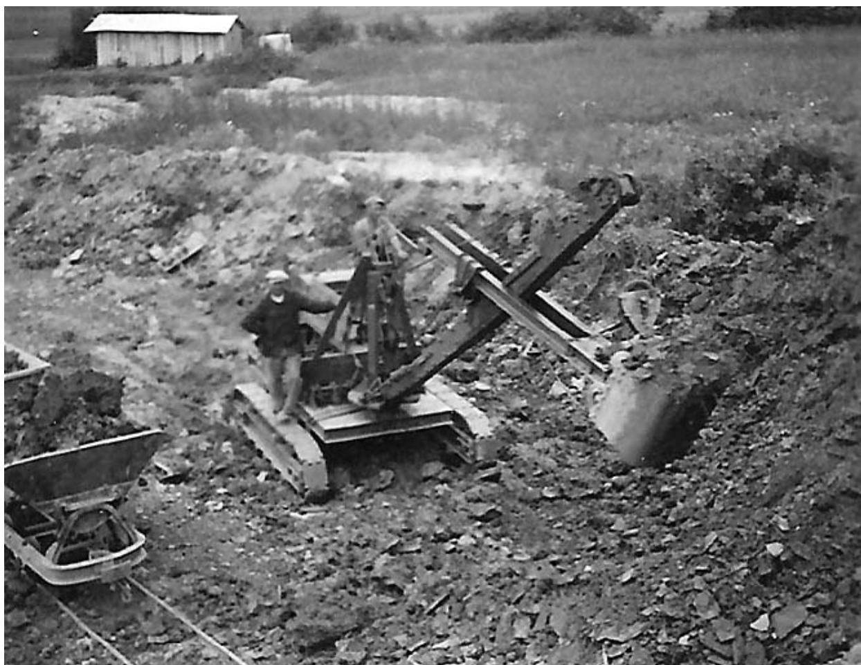
La pelle mécanique. Chargement d'un wagonnet.
