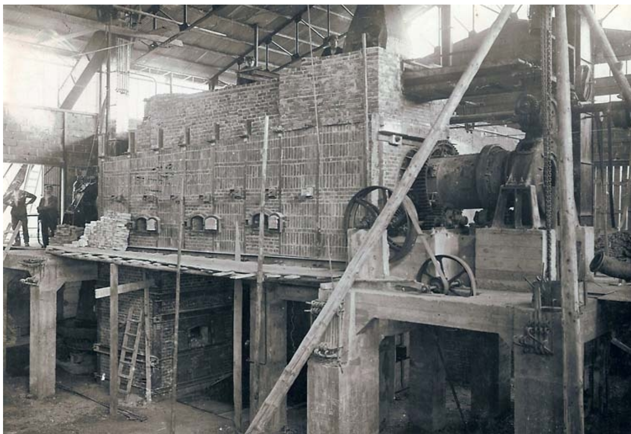
Bâtiment des fours. Four d'essai des schistes.
