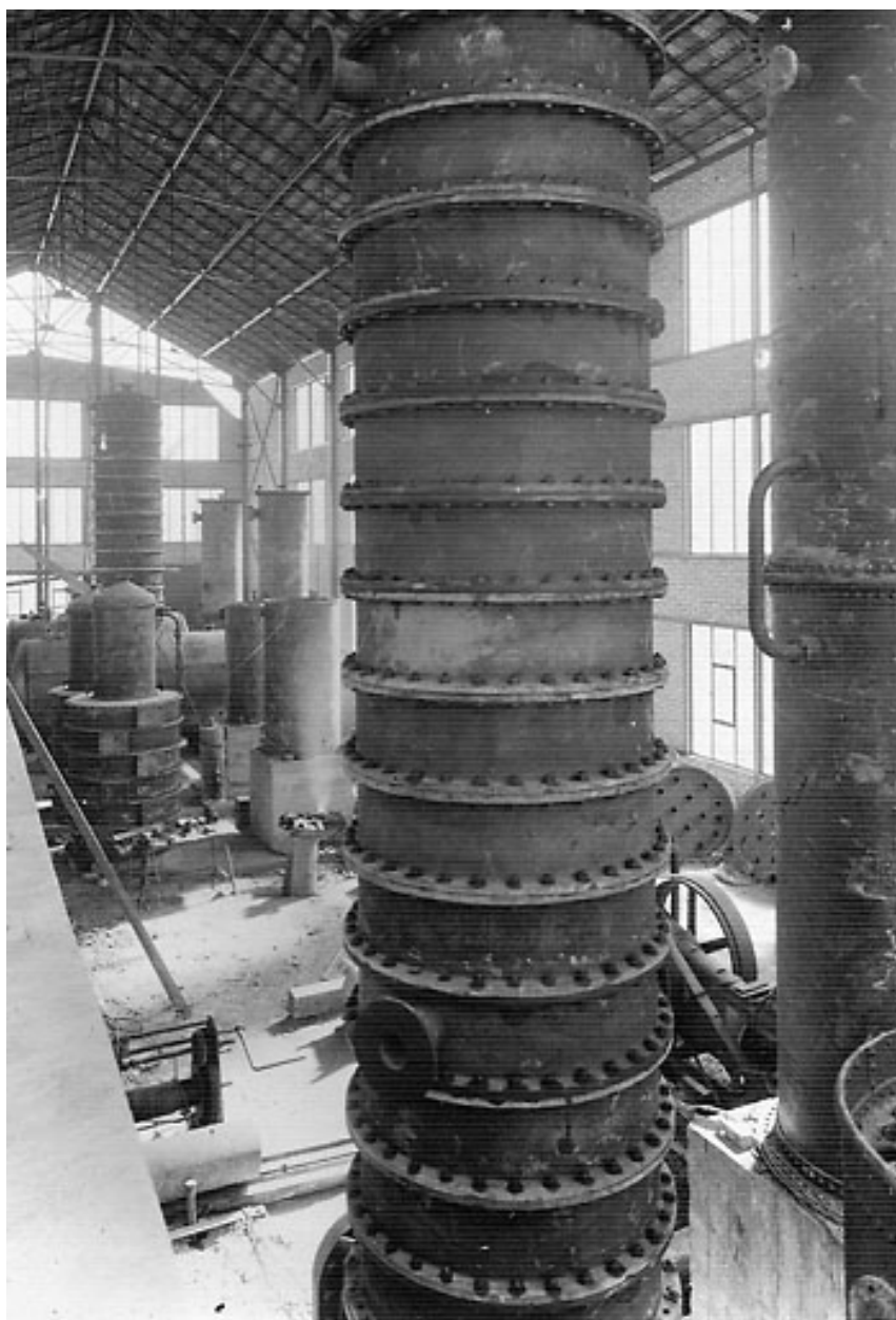
Intérieur de la raffinerie. Colonnes de distillation.
