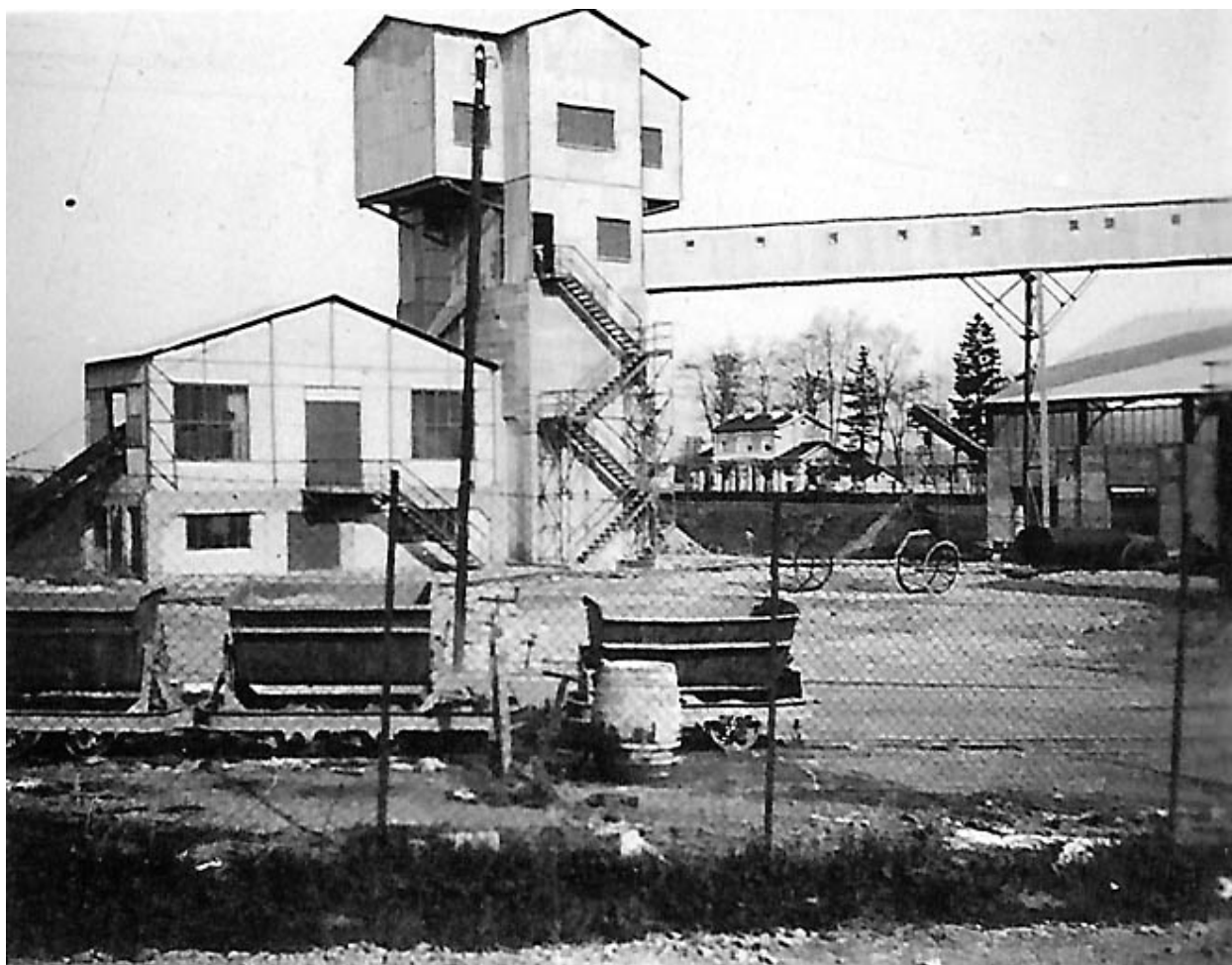
L'ensemble de concassage depuis l'est.
