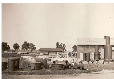
Agrandissement du bâtiment des fours. Phot. Emile Hérissé, Phot. Emile Hérissé IVR43_20077000452NUCA
