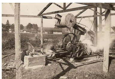
La pompe du forage. Phot. Emile Hérissé, Phot. Emile Hérissé IVR43_20077000450NUCA
