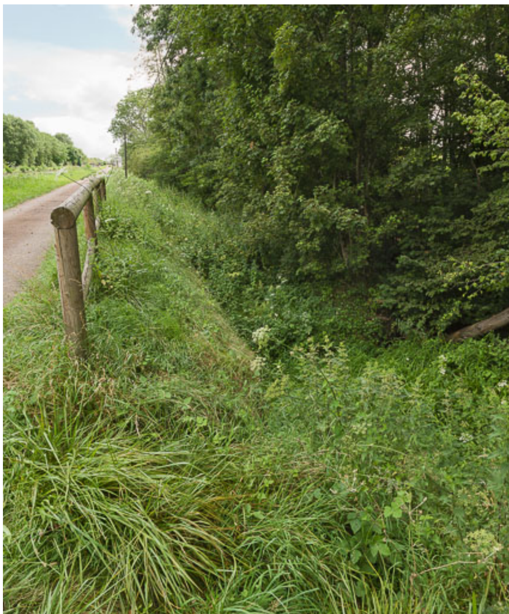
Vue de l'aqueduc.
