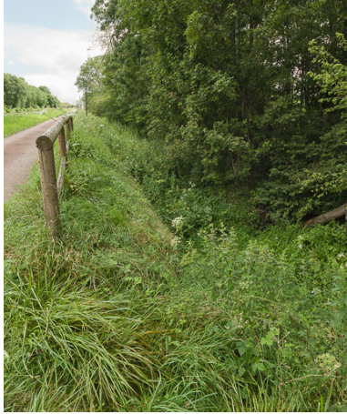
Vue de l'aqueduc.
