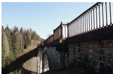
Garde-corps de l'élévation occidentale. Phot. Yves Sancey IVR43_20053900221ZA
