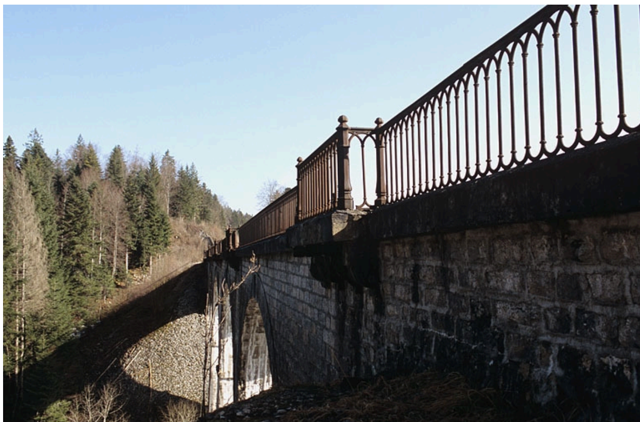
Garde-corps de l'élévation occidentale.
