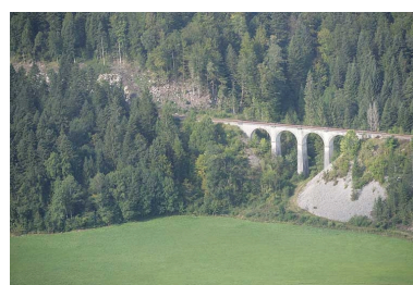
Vue aérienne, depuis le nord-est. Phot. Jean-Pierre Bévalot IVR43_20053900954NUCA
