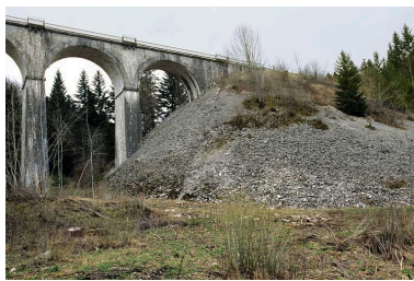
Extrémité et quart de cône côté Andelot-en-Montagne, depuis l'est. Phot. Yves Sancey IVR43_20053900211ZA
