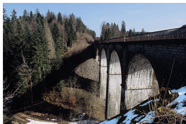
Élévation occidentale vue en enfilade, depuis le côté La Cluse. Phot. Yves Sancey IVR43_20053900220ZA
