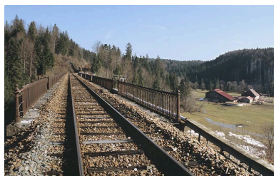
Voie sur le viaduc, depuis le côté La Cluse. Phot. Yves Sancey IVR43_20053900217ZA
