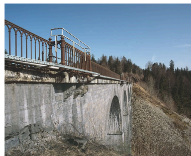
Garde-corps de l'élévation orientale. Phot. Yves Sancey IVR43_20053900215XA
