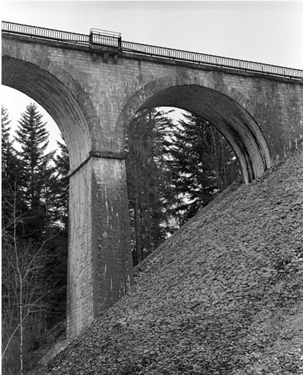
Première arche côté Andelot-en-Montagne, depuis l'est.
