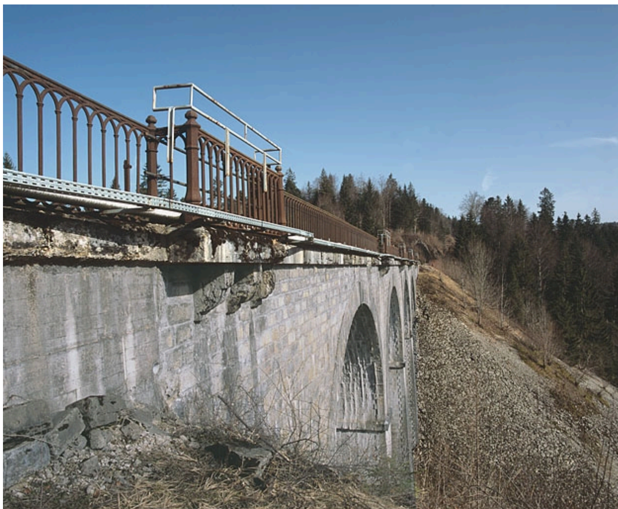
Garde-corps de l'élévation orientale.
