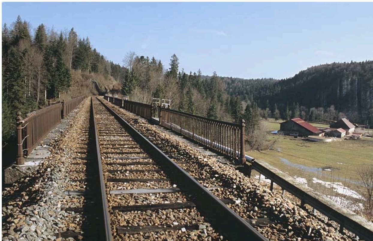
Voie sur le viaduc, depuis le côté La Cluse.
