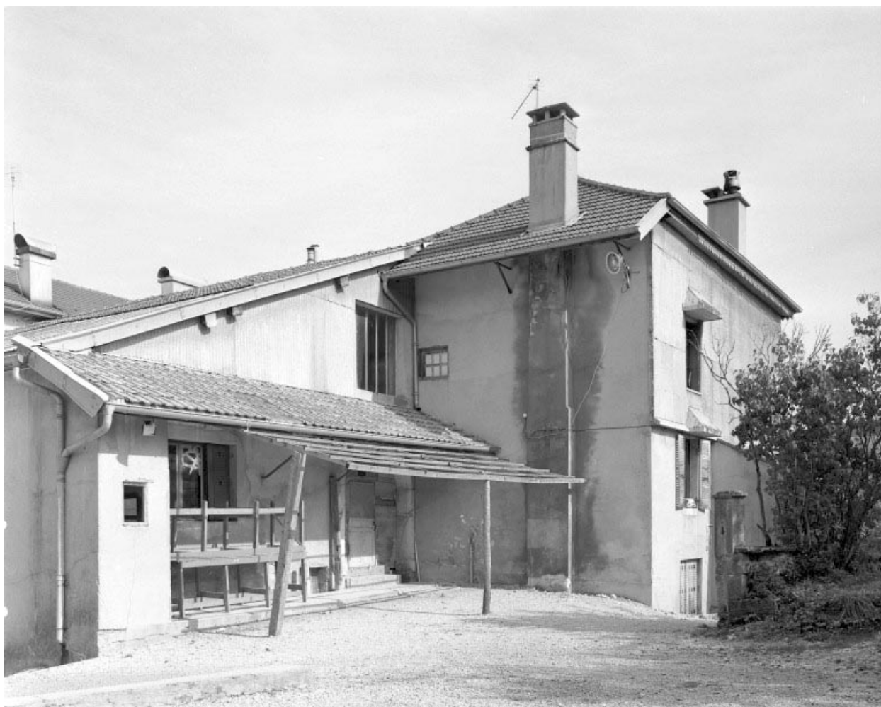
Côté droit du bâtiment.
