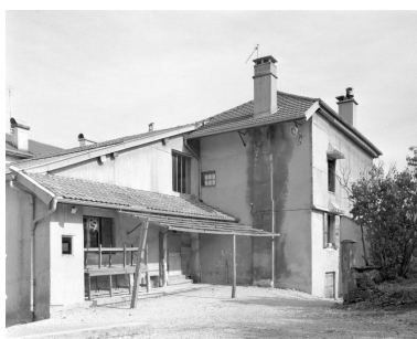
Côté droit du bâtiment. Phot. Jérôme Mongreville IVR43_19943901123X
