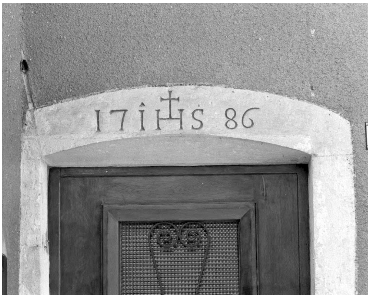
Linteau de la porte du rez-de-chaussée.
