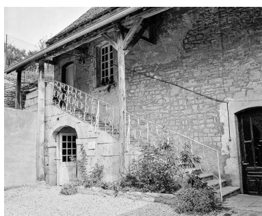
Détail de l'escalier extérieur de l'habitation. Phot. Yves Sancey IVR43_19777000246X
