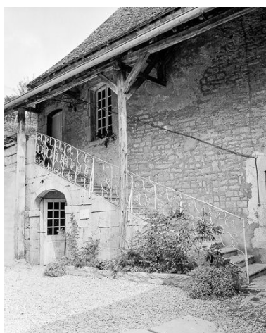
Détail de l'escalier extérieur de l'habitation. Phot. Yves Sancey IVR43_19777000247X
