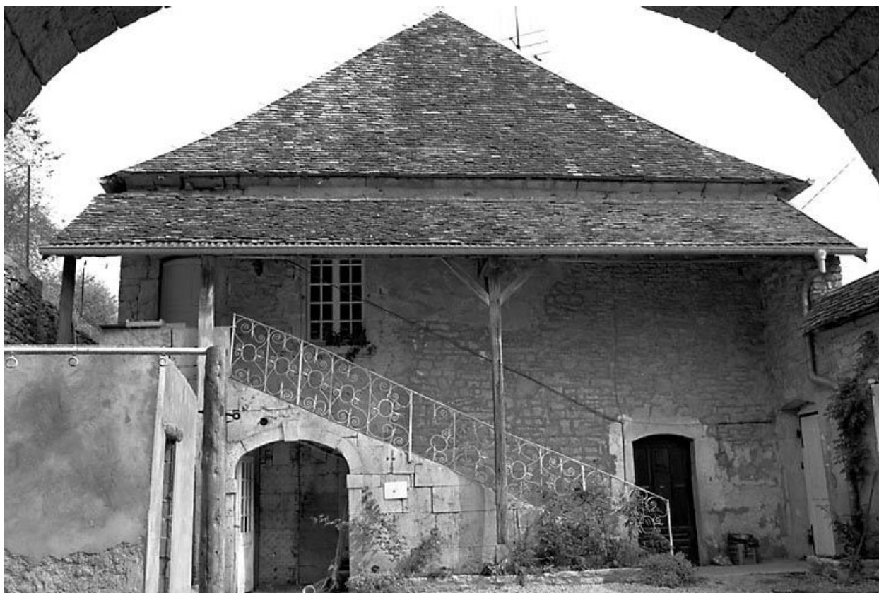
Façade sur cour de l'habitation.
