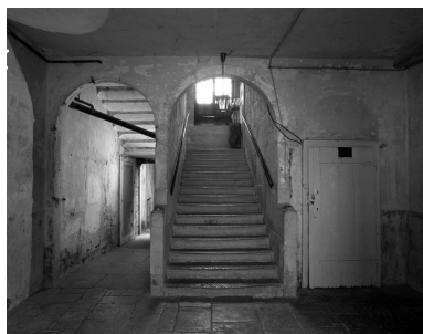
Détail de l'escalier, de face. Phot. Yves Sancey IVR43_19917000163X
