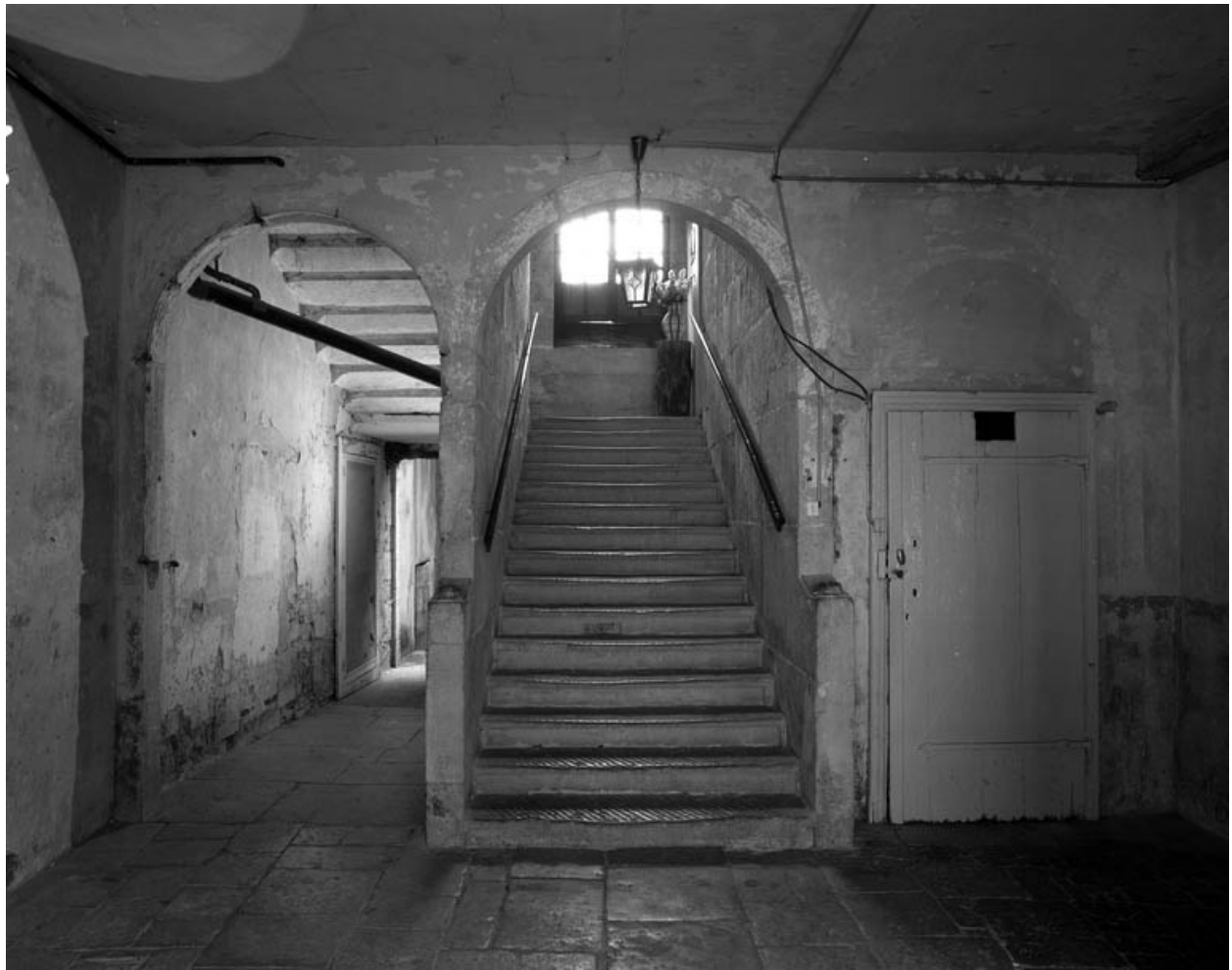
Détail de l'escalier, de face.
