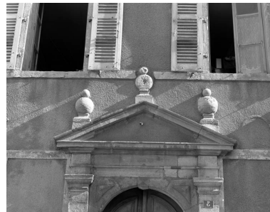
Portail d'entrée : détail du fronton. Phot. Yves Sancey IVR43_19897000275X
