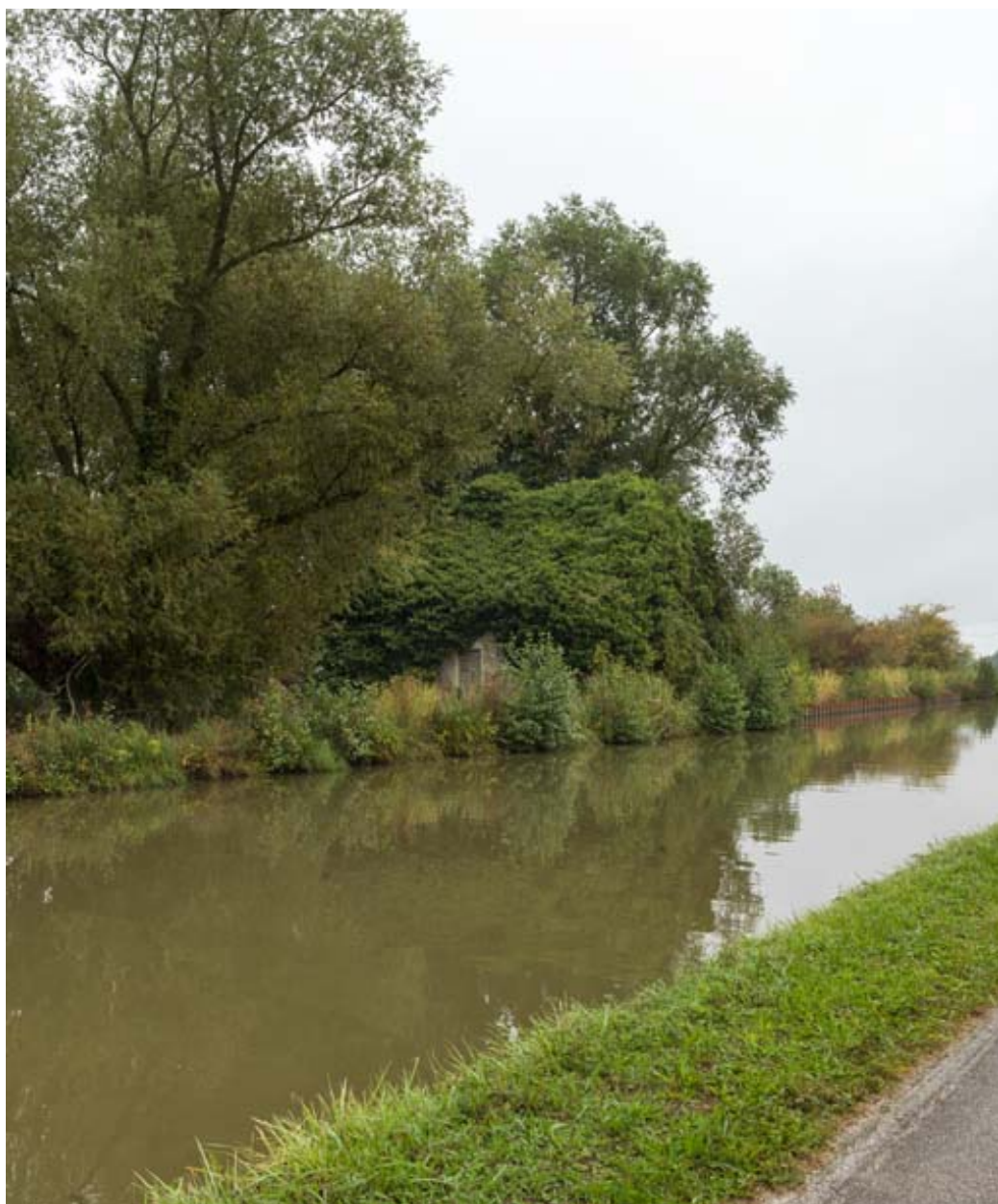
Ancienne maison éclusière, envahie par la végétation.
