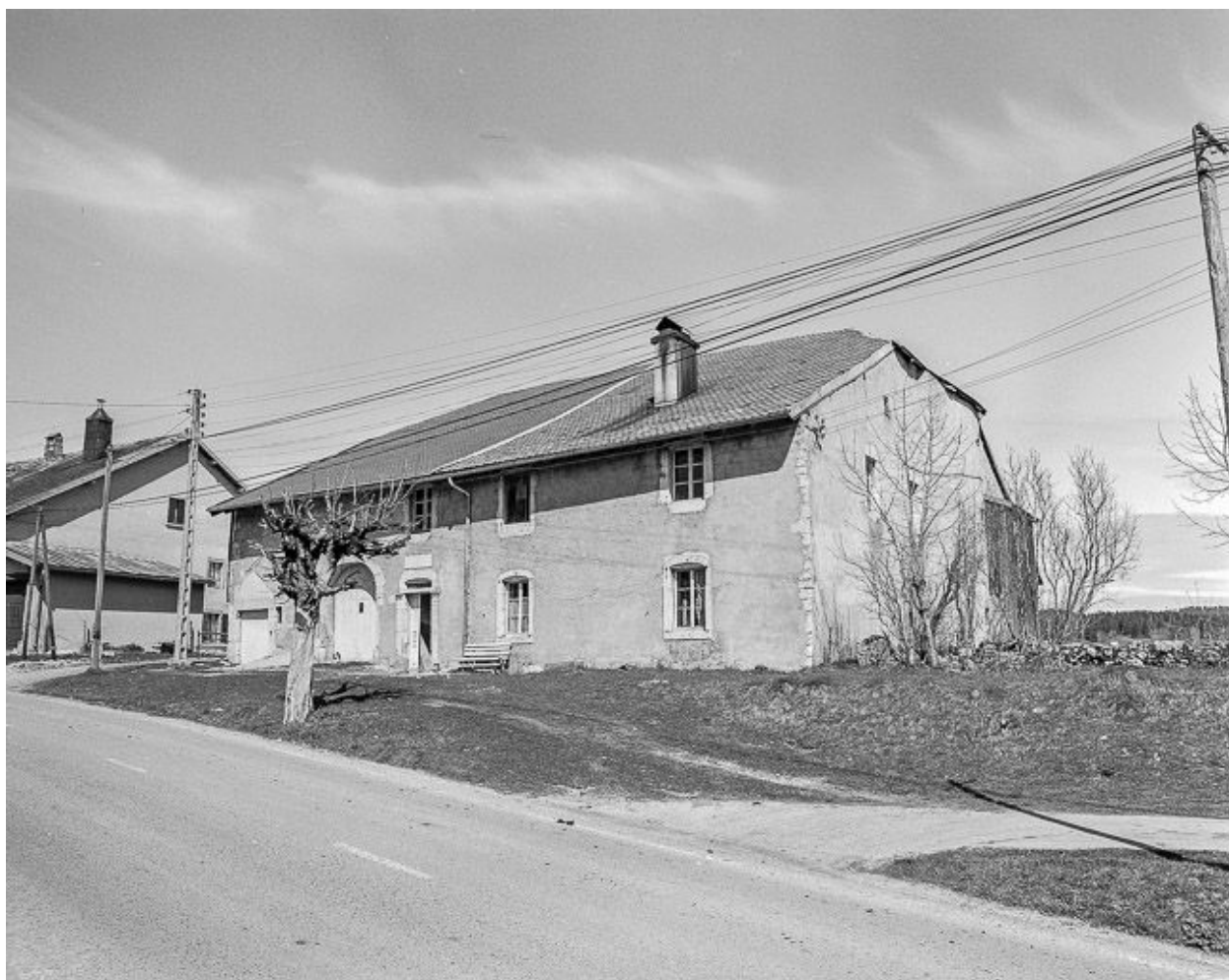
Façades antérieure et latérale droite.
