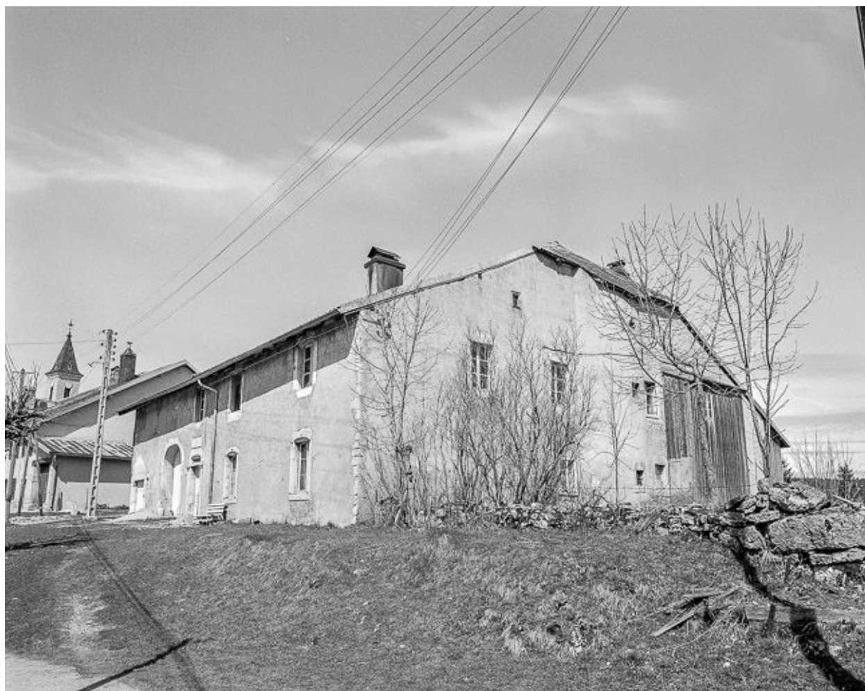
Façades antérieure et latérale droite.
