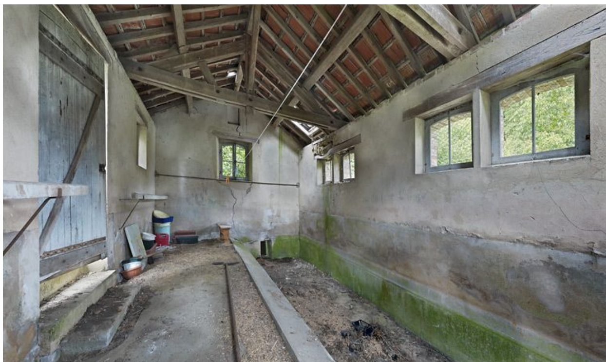
Intérieur du lavoir.
