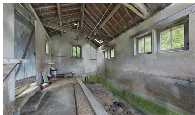
Intérieur du lavoir. Phot. Thierry Kuntz IVR26_20118900090NUC4AQ
