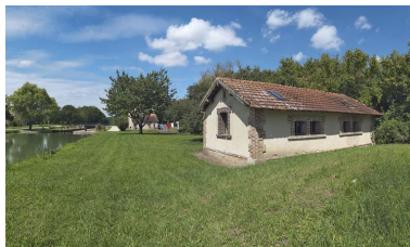
Vue d'ensemble du lavoir. Phot. Thierry Kuntz IVR26_20118900088NUC4A
