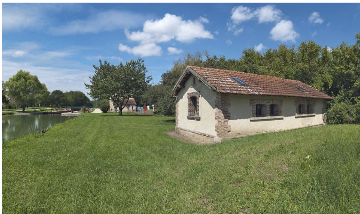
Vue d'ensemble du lavoir.
