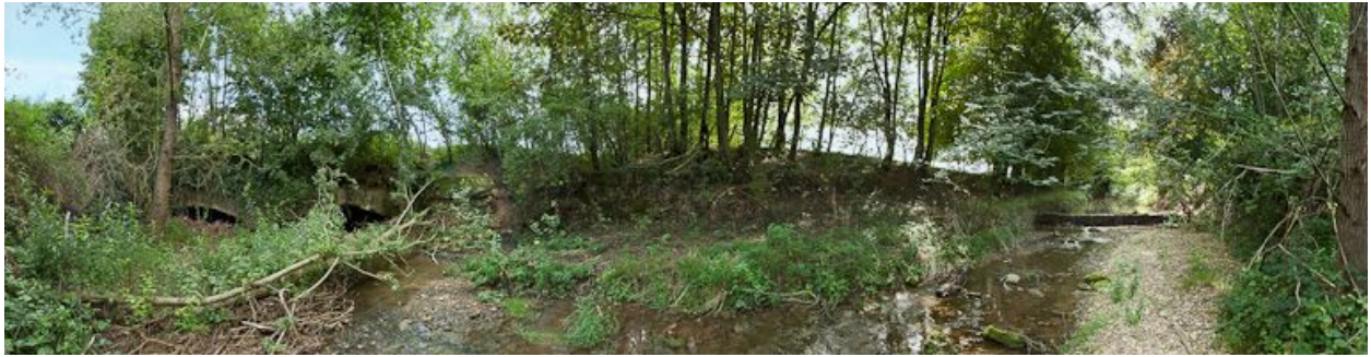
Vue générale de l'ouvrage.
