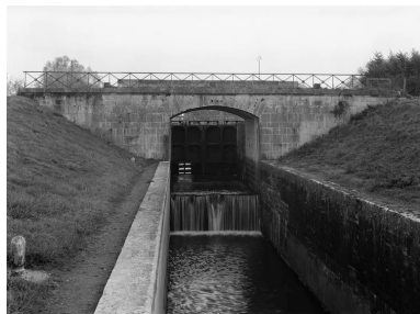
Le sas et le pont sur écluse (en 1975).
