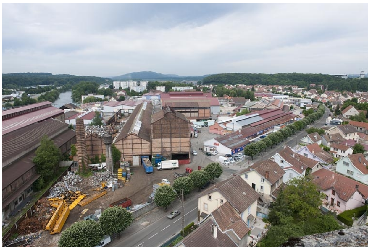
Audincourt, usine des Forges : vue plongeante sur la partie nord.
