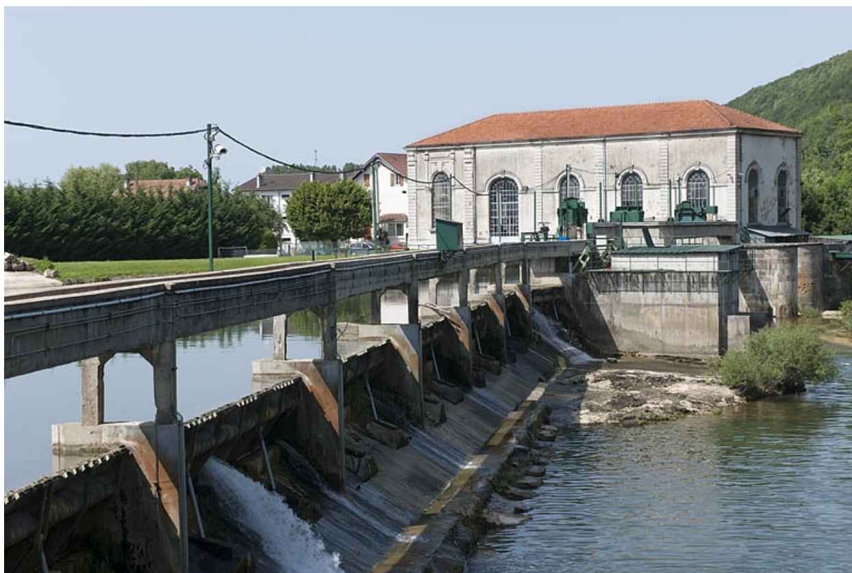
Mathay, centrale hydroélectrique : les déversoirs du barrage et de la centrale
