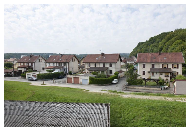
Audincourt, cité ouvrière de la Compagnie des forges dite cité Keller : vue d'ensemble depuis l'est Phot. Jérôme Mongreville IVR43_20112502022NUC4A
