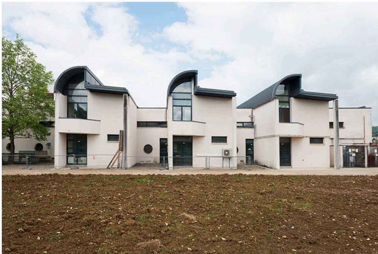
Façades postérieures sud-est des ateliers.
