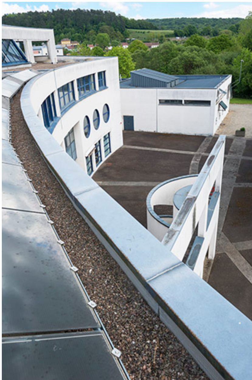
Détail de la toiture de l'externat sur cour et vue sur l'escalier.
