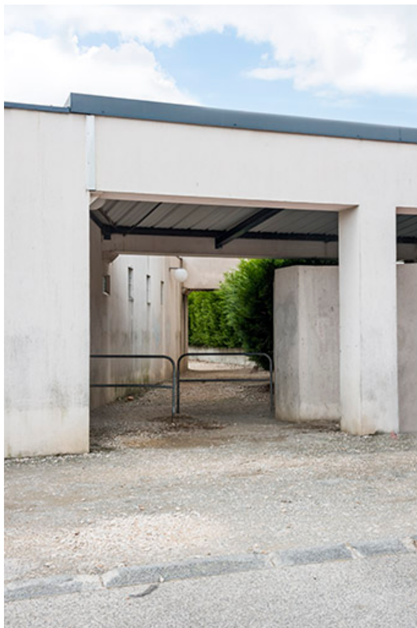
Détail du passage de la rue Mendès France vers la cour.
