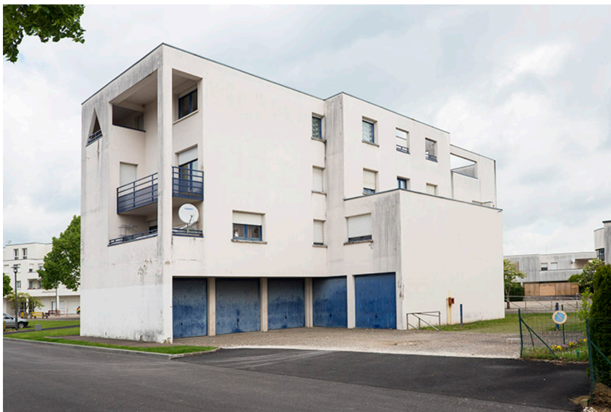
Angle sud-ouest des logements ouest.
