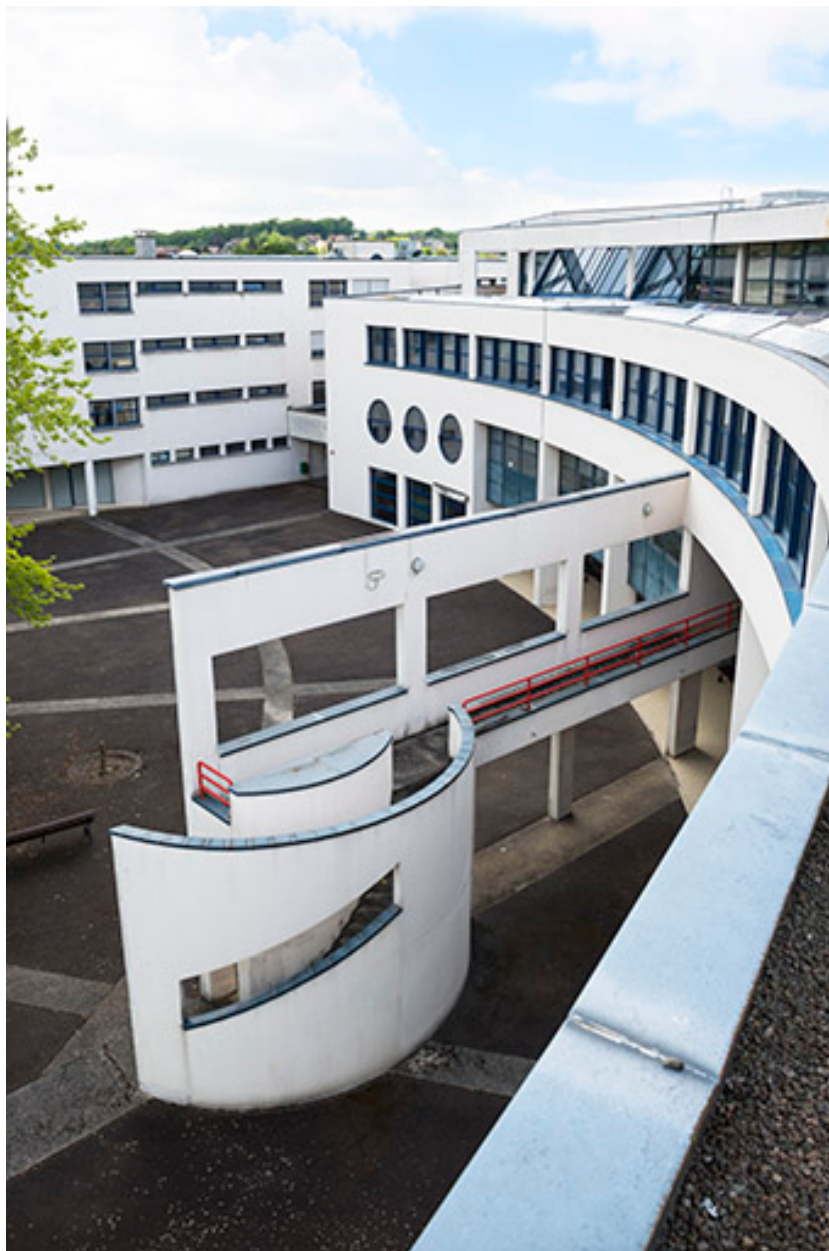
Sud-ouest de la cour postérieure, angle nord-est de l'internat et façade sud de l'externat semi-circulaire.
