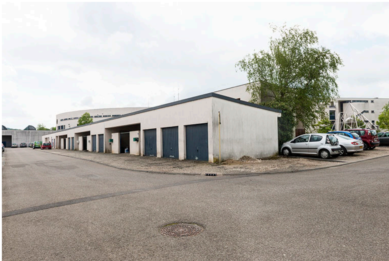
Les façades nord le long de la rue Mendès France.
