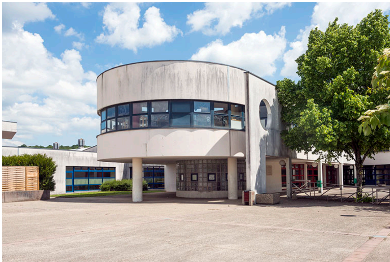
Détail de la façade antérieure nord de la proue de l'externat.
