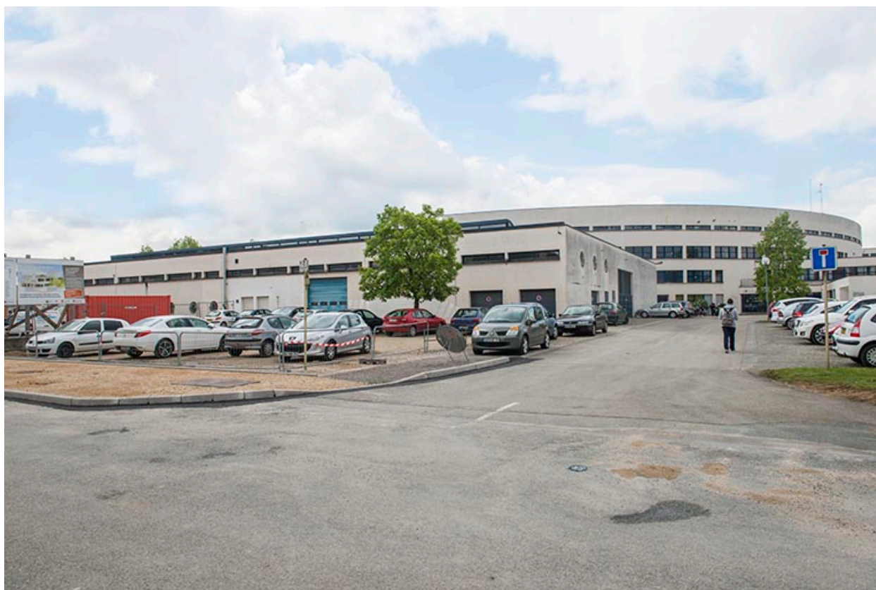
Les façades de l'externat et de l'atelier depuis le nord-est.
