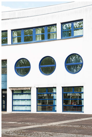
Détail de la façade postérieure sud de l'externat. Phot. Mary Ruffinoni IVR43_20147000011NUC4A
