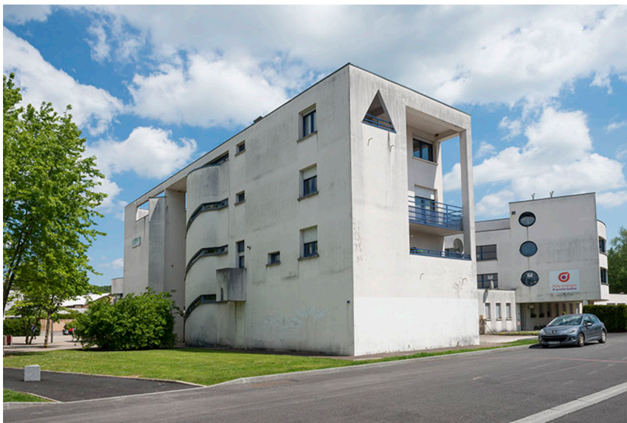
Vue depuis l'angle nord-ouest des logements sud-ouest.
