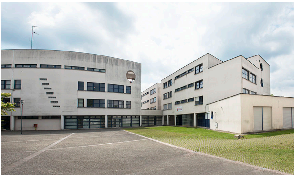
Cour et façade antérieure nord-ouest de l'externat et façade nord de l'internat.
