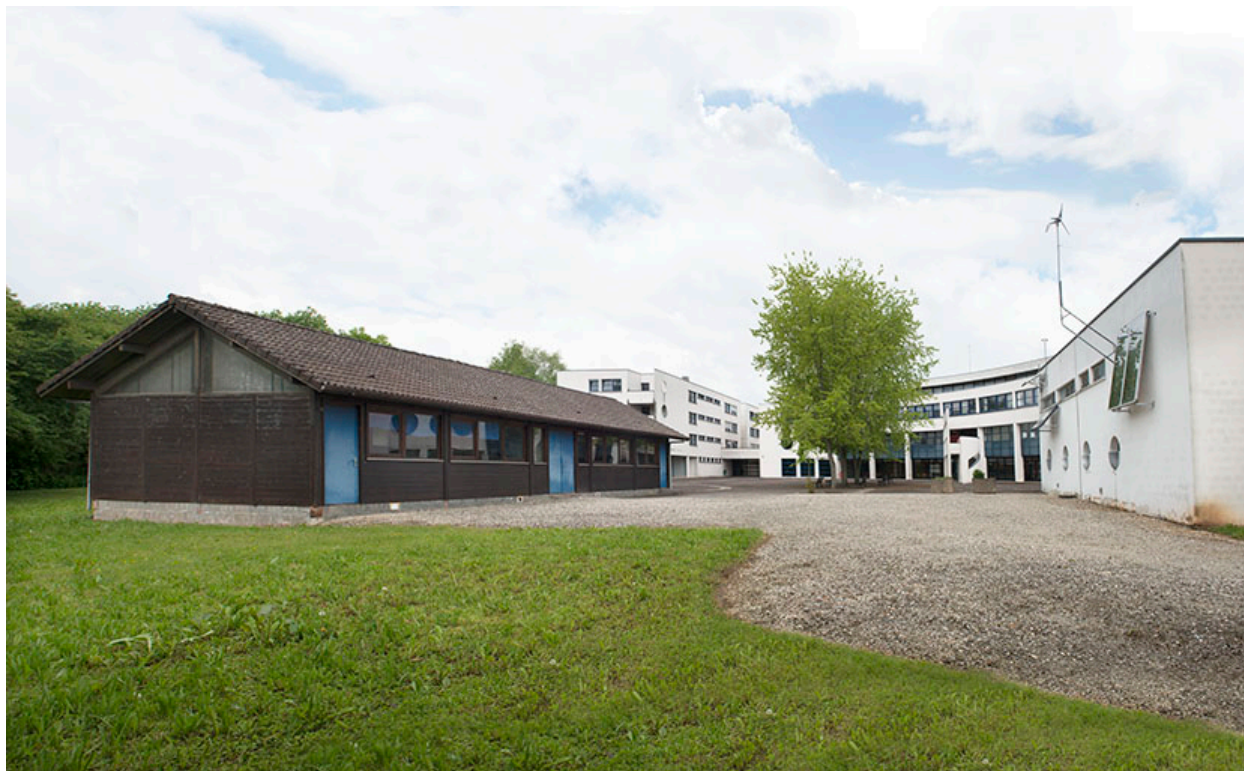
Angle sud-est du chalet et cour postérieure.
