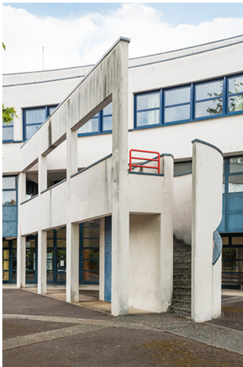
Détail de l'escalier hors-oeuvre dans la cour postérieure.
