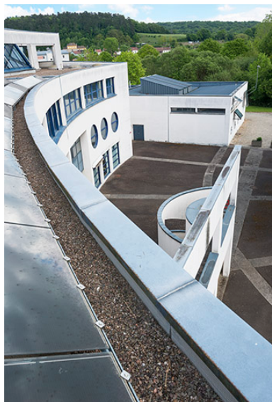
Détail de la toiture de l'externat sur cour et vue sur l'escalier. Phot. Mary Ruffinoni IVR43_20147000026NUC4A
