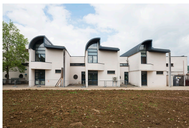
Façades postérieures sud-est des ateliers. Phot. Mary Ruffinoni IVR43_20147000016NUC4A
