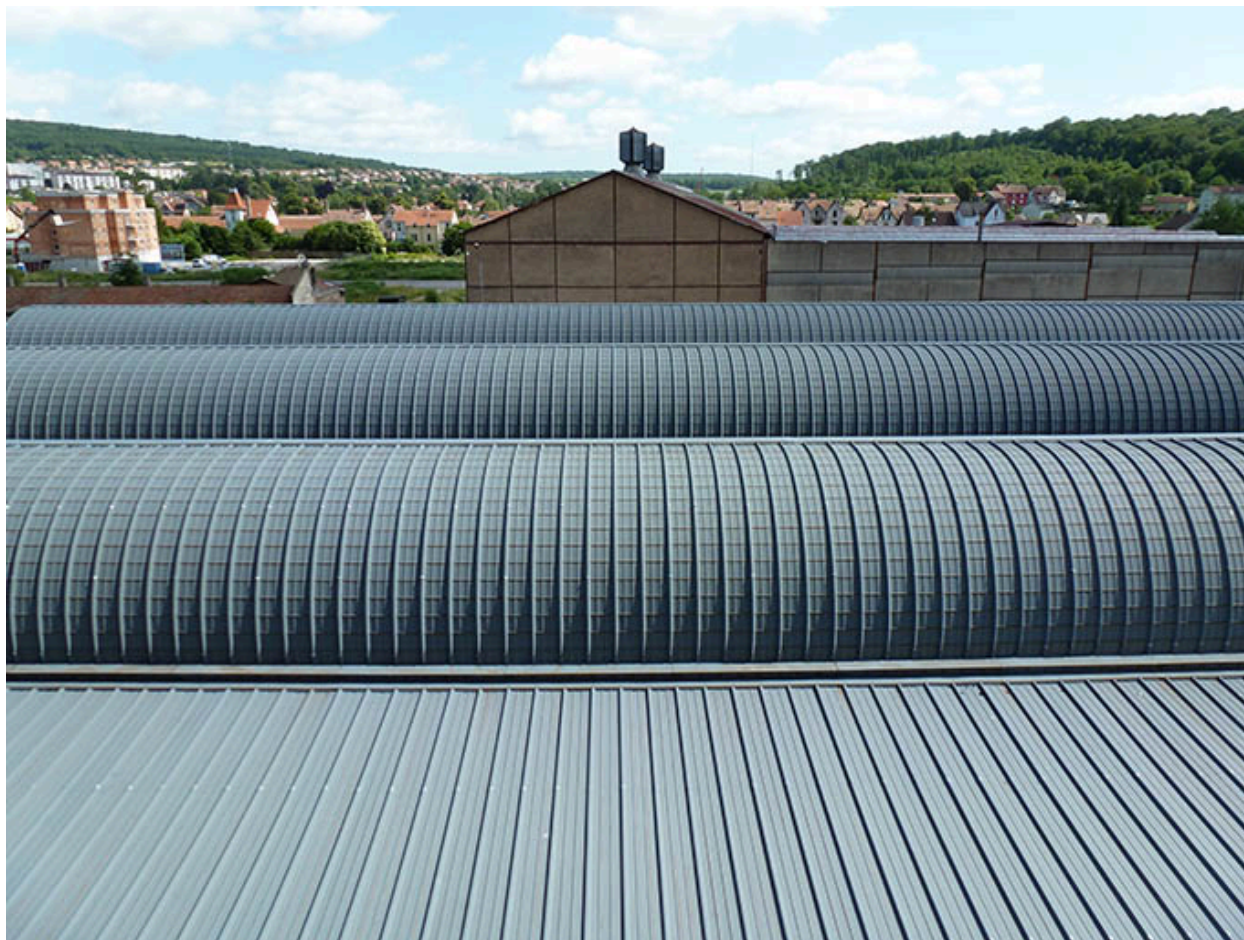
Toiture des ateliers.
