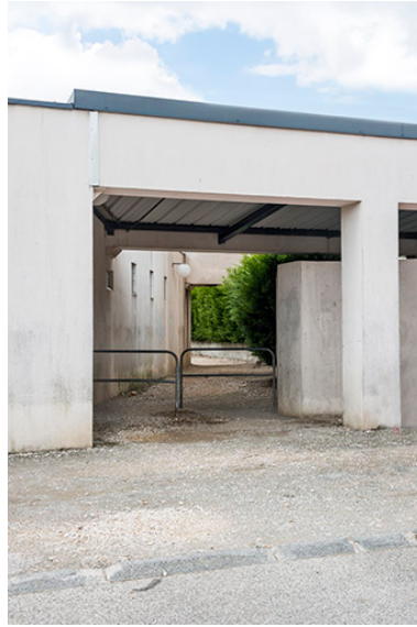
Détail du passage de la rue Mendès France vers la cour. Phot. Mary Ruffinoni IVR43_20147000002NUC4A
