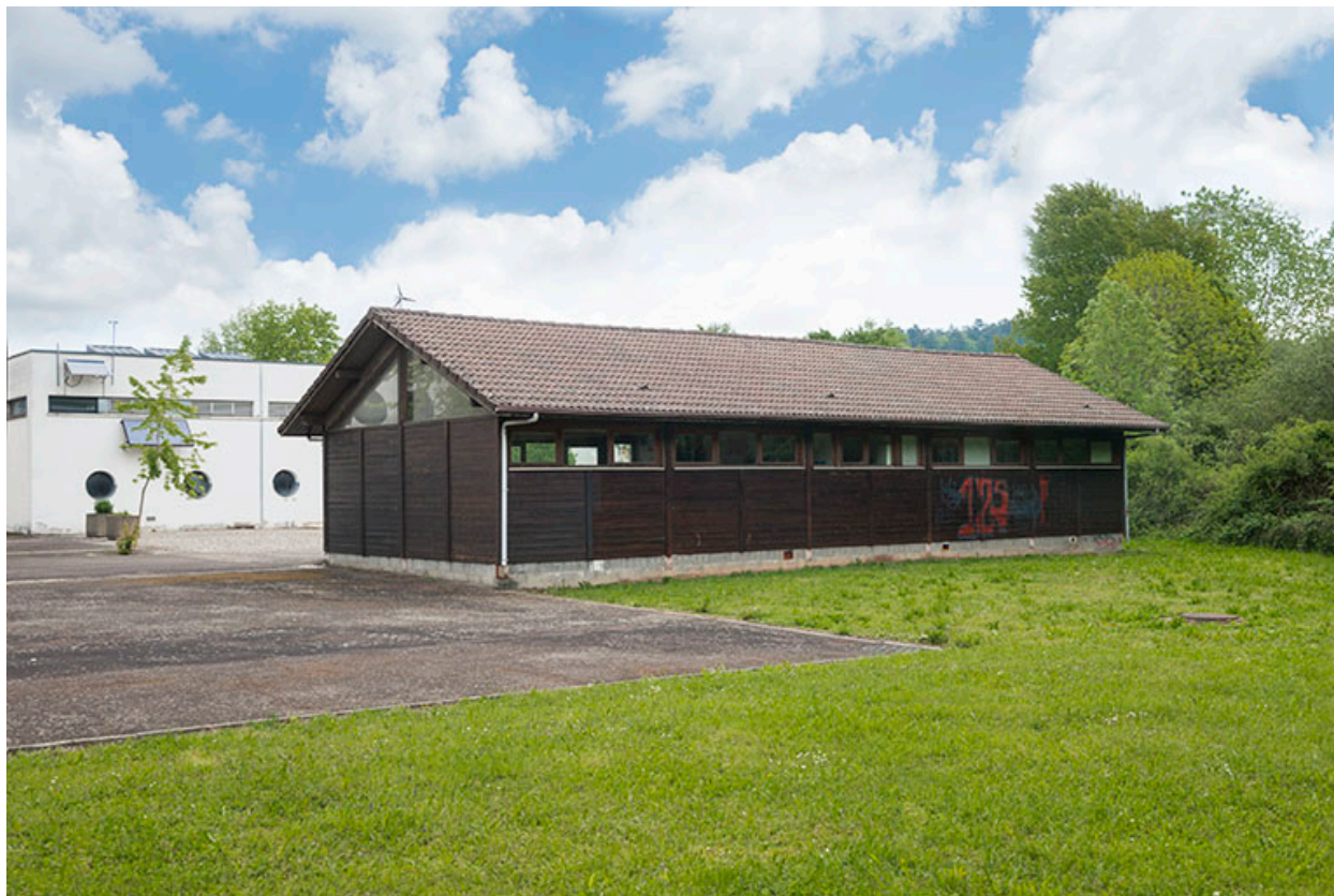
Angle sud-ouest du chalet dans la cour.
