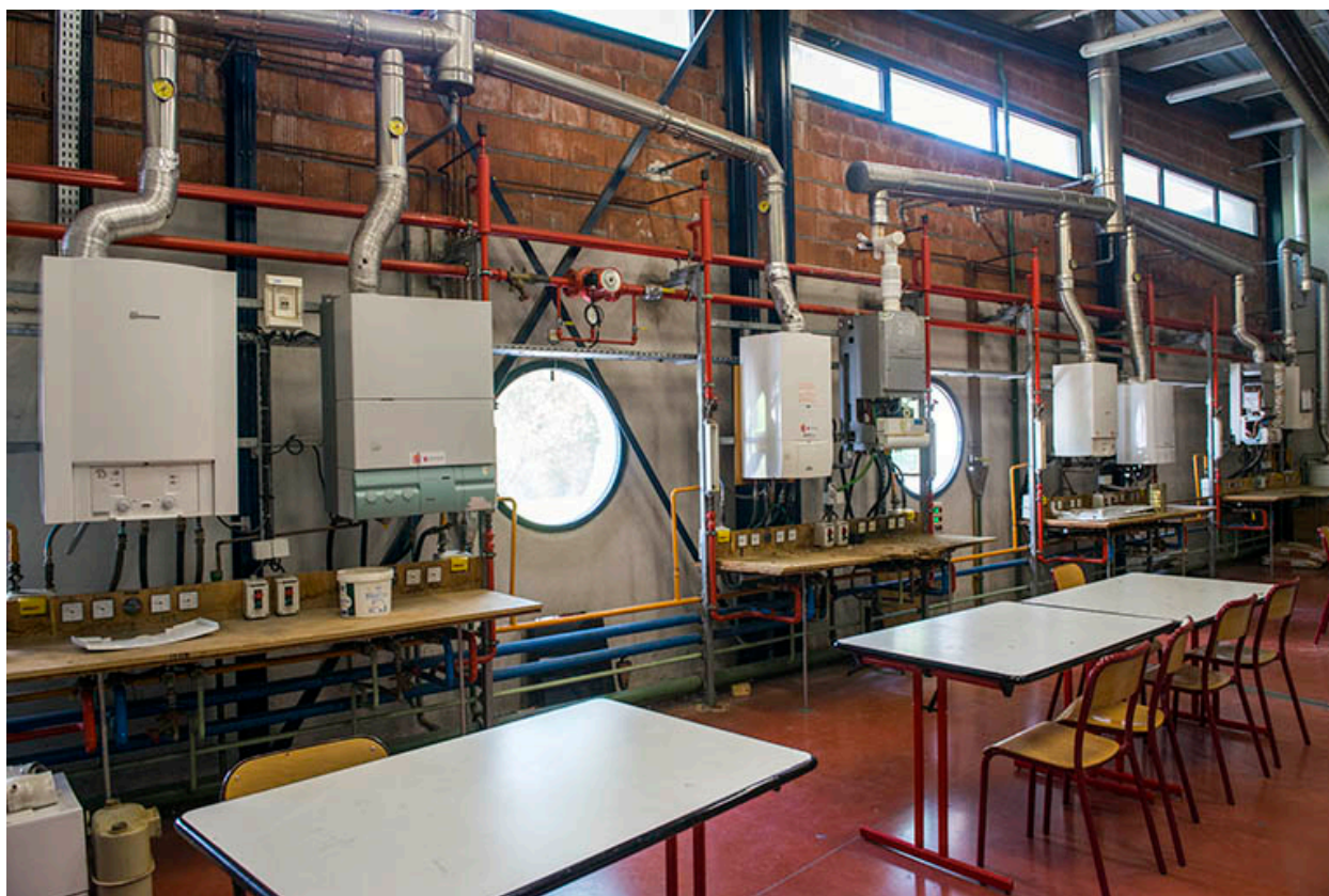
Vue intérieure des ateliers du pôle énergie.
