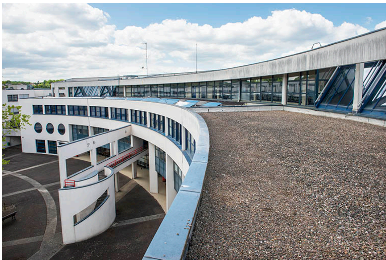
Détail de la terrasse de l'externat semi-circulaire.
