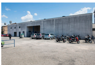
Façade ouest de l'atelier. Phot. Mary Ruffinoni IVR43_20147000017NUC4A
