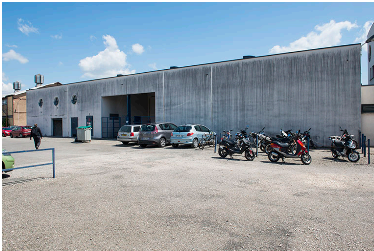
Façade ouest de l'atelier.
