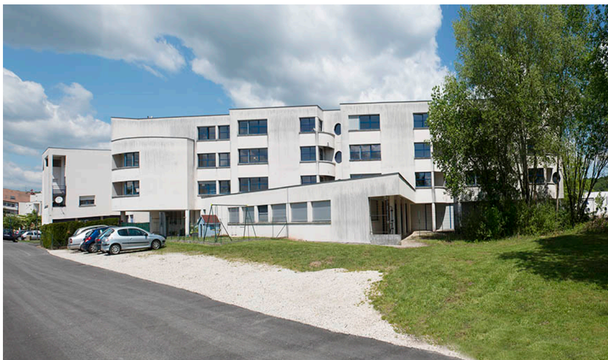
Façades ouest de l'internat.
