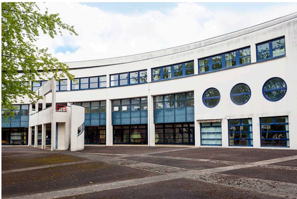
Cour et façade postérieure sud de l'externat.
