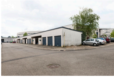
Les façades nord le long de la rue Mendès France. Phot. Mary Ruffinoni IVR43_20147000003NUC4A
