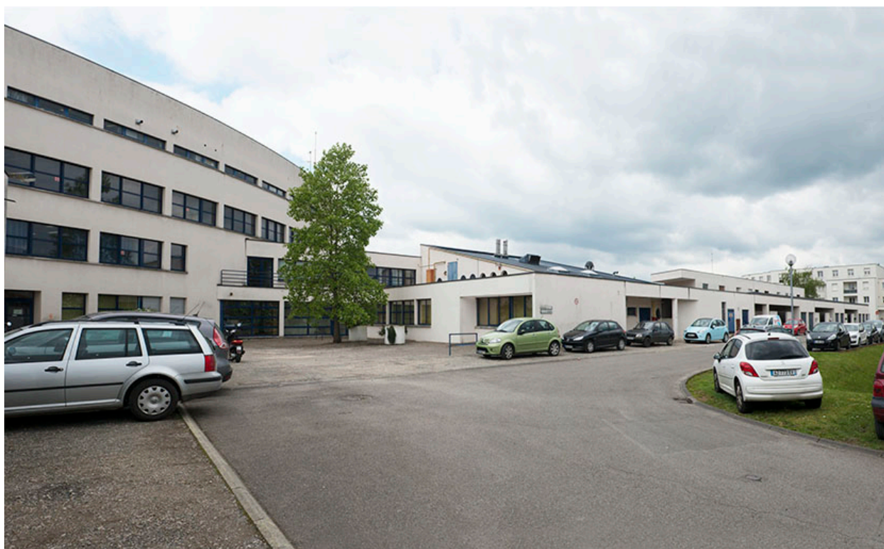
Cour postérieure nord, dite cour d'honneur, au nord de l'externat semi-circulaire, angle nord-est des cuisines et façade nord, garages rue Mendès France.
