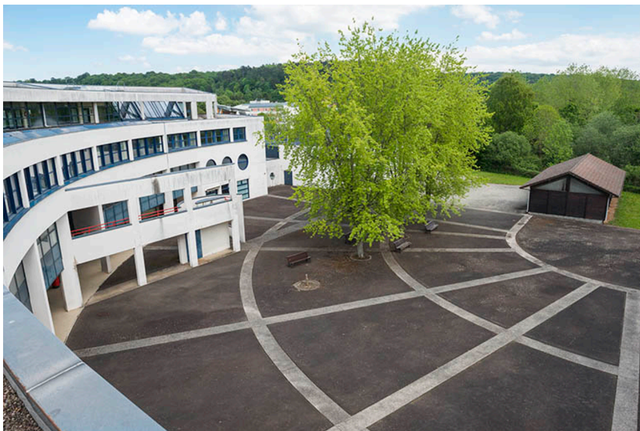
Cour et façade postérieure sud de l'externat.
