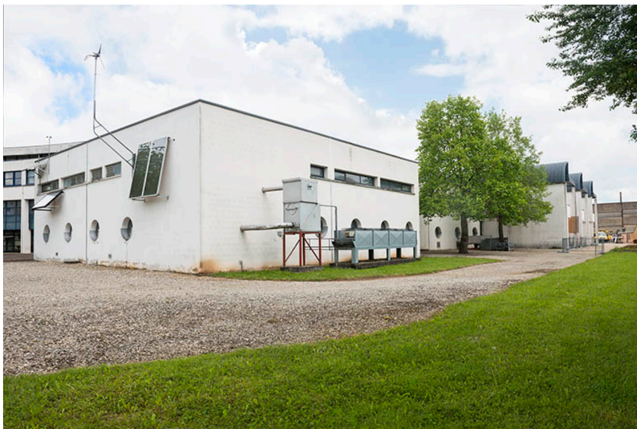
Angle sud de l'extension sud-ouest de l'atelier.
