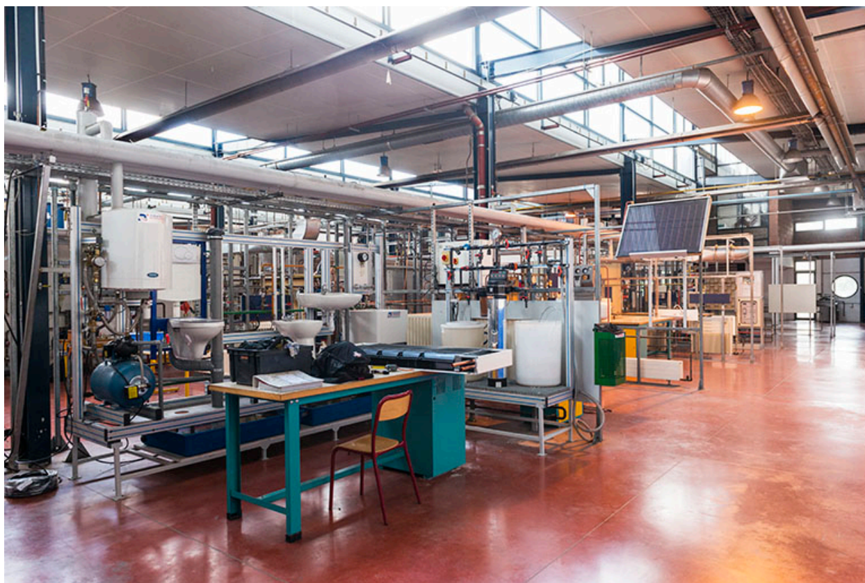
Vue intérieure des ateliers du pôle énergie.
