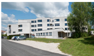
Façades ouest de l'internat. Phot. Mary Ruffinoni IVR43_20147000039NUC4A
