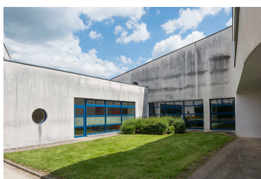
Jonction de l'externat avec logements, au nord-est de la proue de l'externat. Phot. Mary Ruffinoni IVR43_20147000020NUC4A
