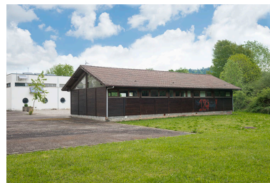
Angle sud-ouest du chalet dans la cour. Phot. Mary Ruffinoni IVR43_20147000014NUC4A
