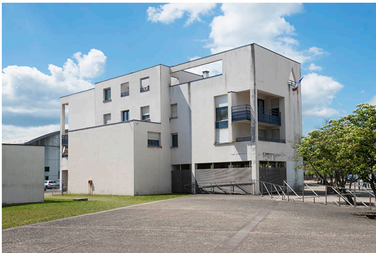
Angle sud-est des logements ouest.
