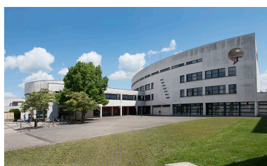
Cour et façade antérieure nord-ouest de l'externat. Phot. Mary Ruffinoni IVR43_20147000043NUC4A
