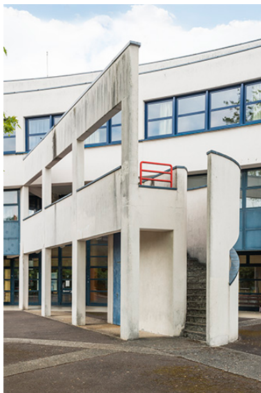
Détail de l'escalier hors- oeuvre dans la cour postérieure. Phot. Mary Ruffinoni IVR43_20147000012NUC4A
