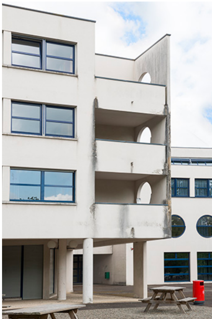
Détail de l'angle est de l'internat sur cour.
