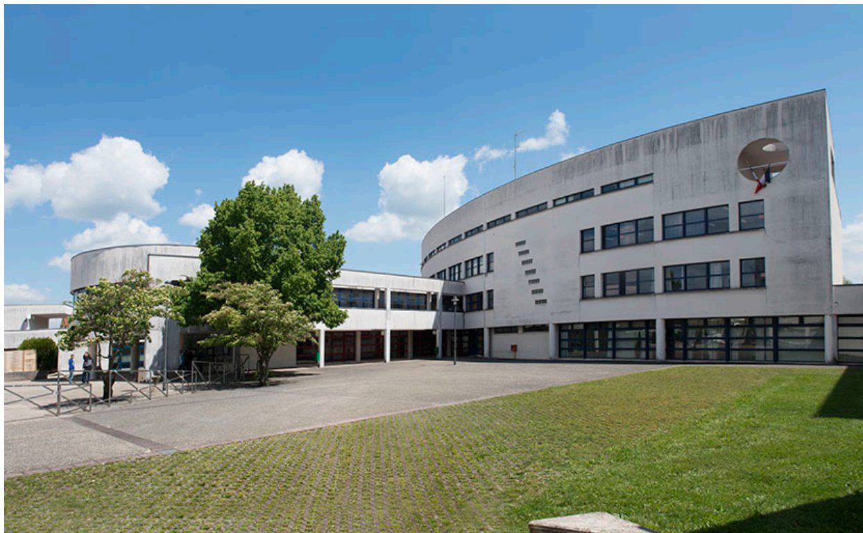
Cour et façade antérieure nord-ouest de l'externat.
