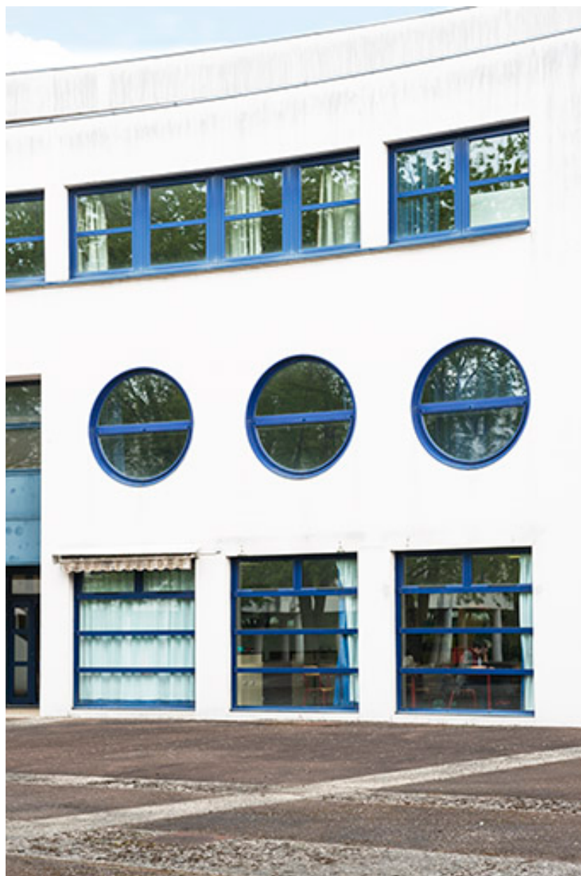
Détail de la façade postérieure sud de l'externat.
