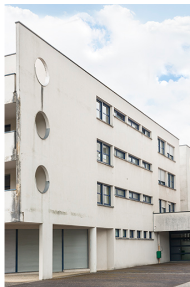
Angle nord-est de l'internat et sa façade nord-est sur cour postérieure. Phot. Mary Ruffinoni IVR43_20147000009NUC4A
