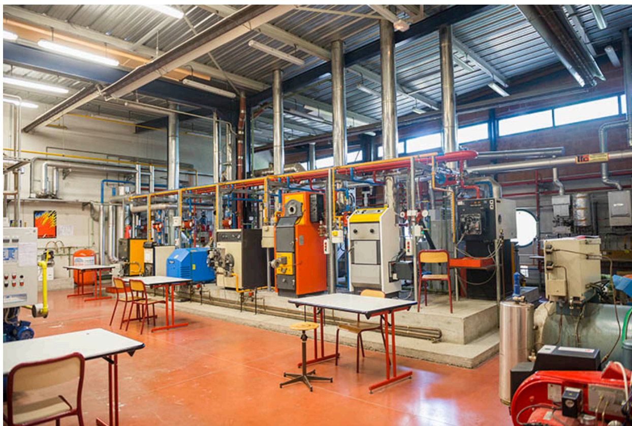
Vue intérieure des ateliers du pôle énergie.
