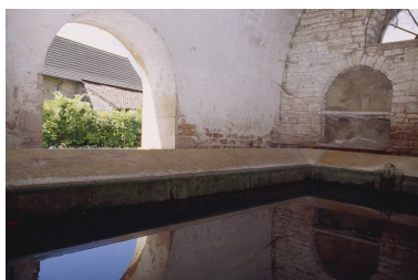
Vue intérieure. Phot. Jacques Druart IVR26_19967100818ZA
