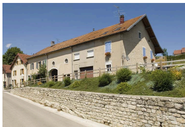
Vue générale. Phot. Jérôme Mongreville IVR43_20092500963NUC2A
