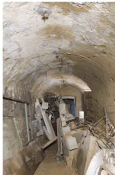
"Cave" derrière la grange. Phot. Jérôme Mongreville IVR43_20082500796NUC2A
