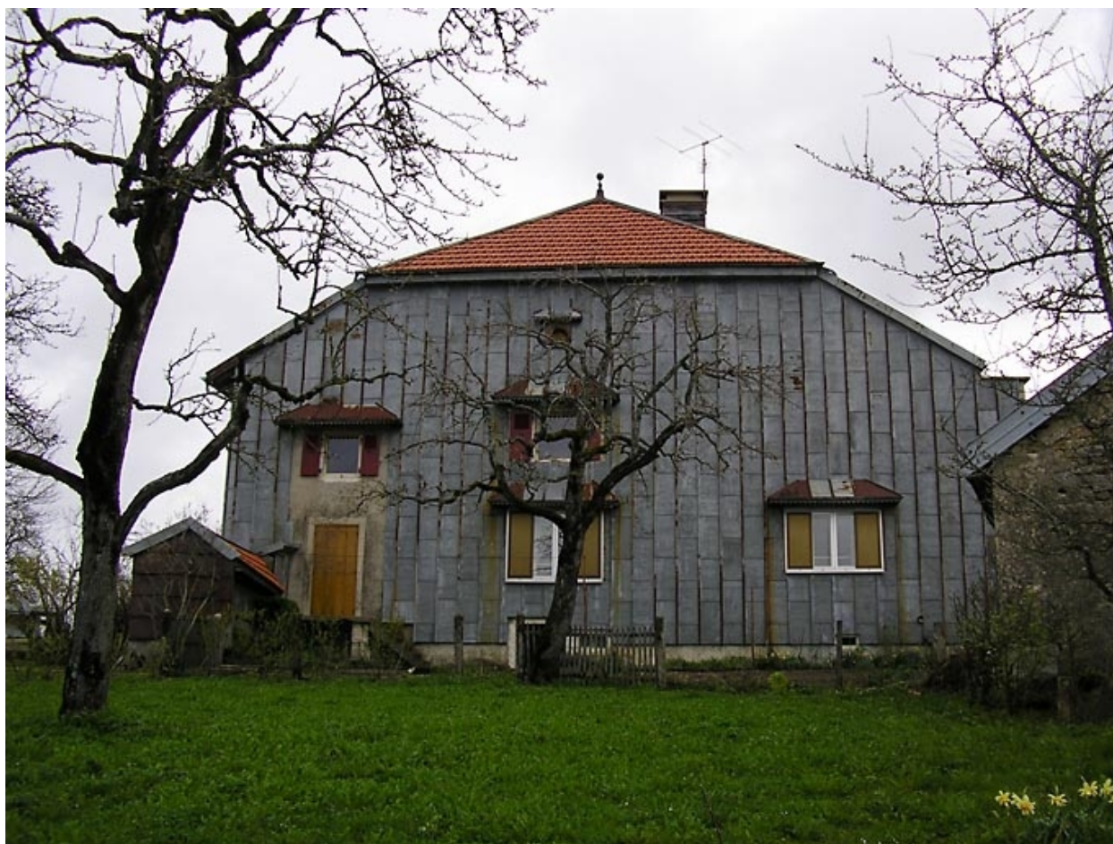
Vue générale du pignon sud-ouest.
