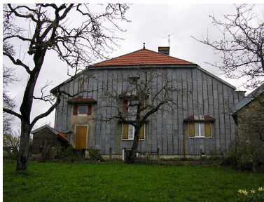
Vue générale du pignon sud-ouest.
