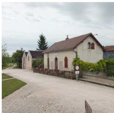
Vue de la maison éclusière. Phot. Pierre-Marie Barbe-Richaud IVR26_20118900367NUC2AQ
