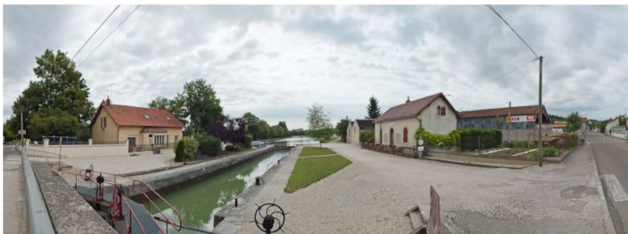
Vue d'ensemble du site d'écluse.
