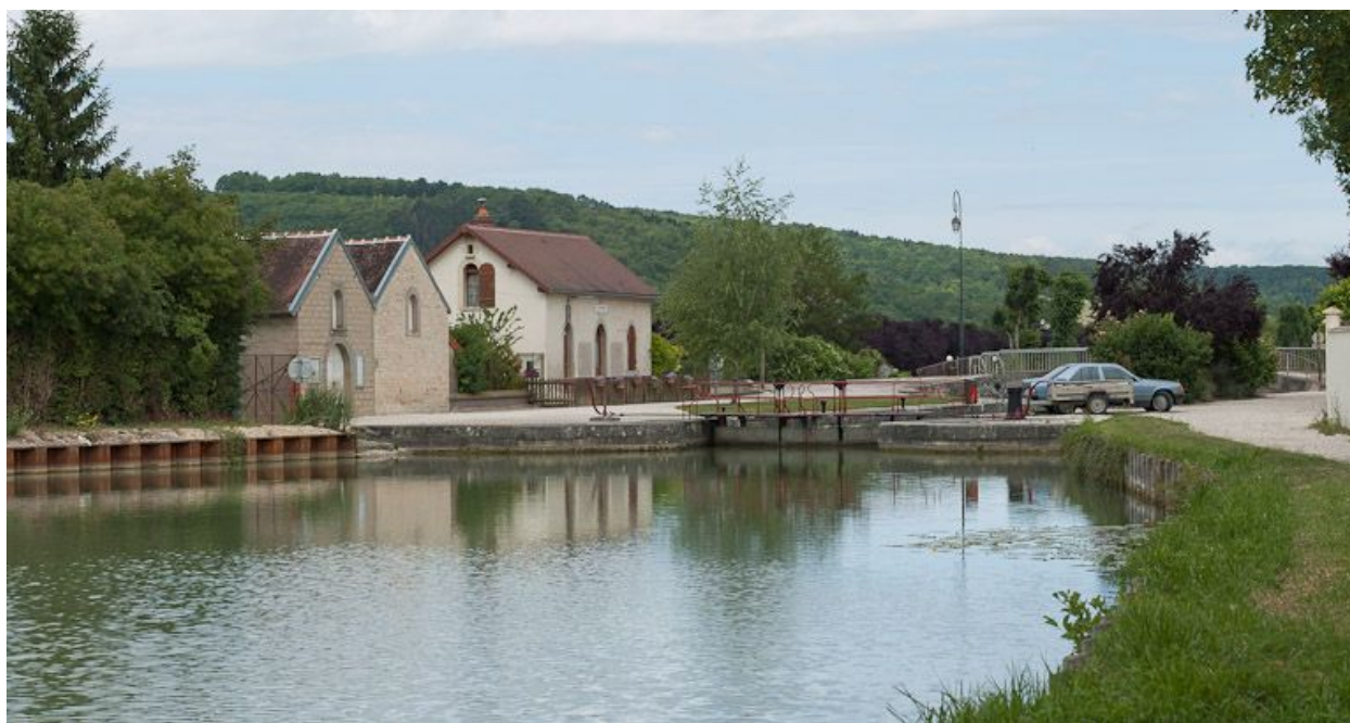
Vue du site d'écluse depuis l'amont.
