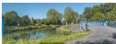
Vue du dessus, avec à gauche le site d'écluse 18. Phot. Thierry Kuntz IVR26_20162101278NUC4A
