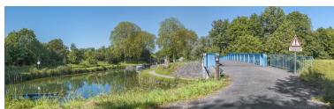
Vue du dessus, avec à gauche le site d'écluse 18. Phot. Thierry Kuntz IVR26_20162101277NUC4A
