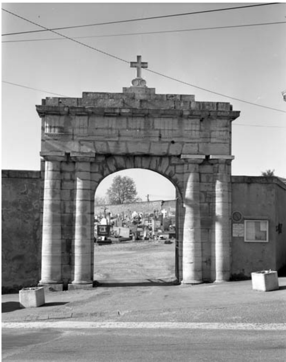
Vue du portail d'entrée : de face.
