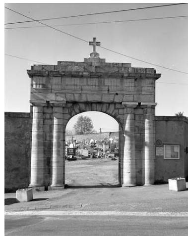
Vue du portail d'entrée : de face.
