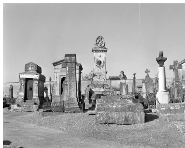
Vue partielle de la partie ancienne. Phot. Yves Sancey IVR43_19907000065X
