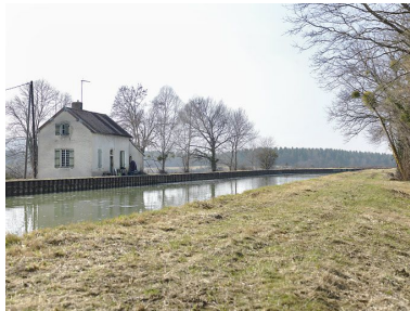
La maison de 3/4 avec le pignon. Phot. Thierry Kuntz IVR26_20122102629NUC4A
