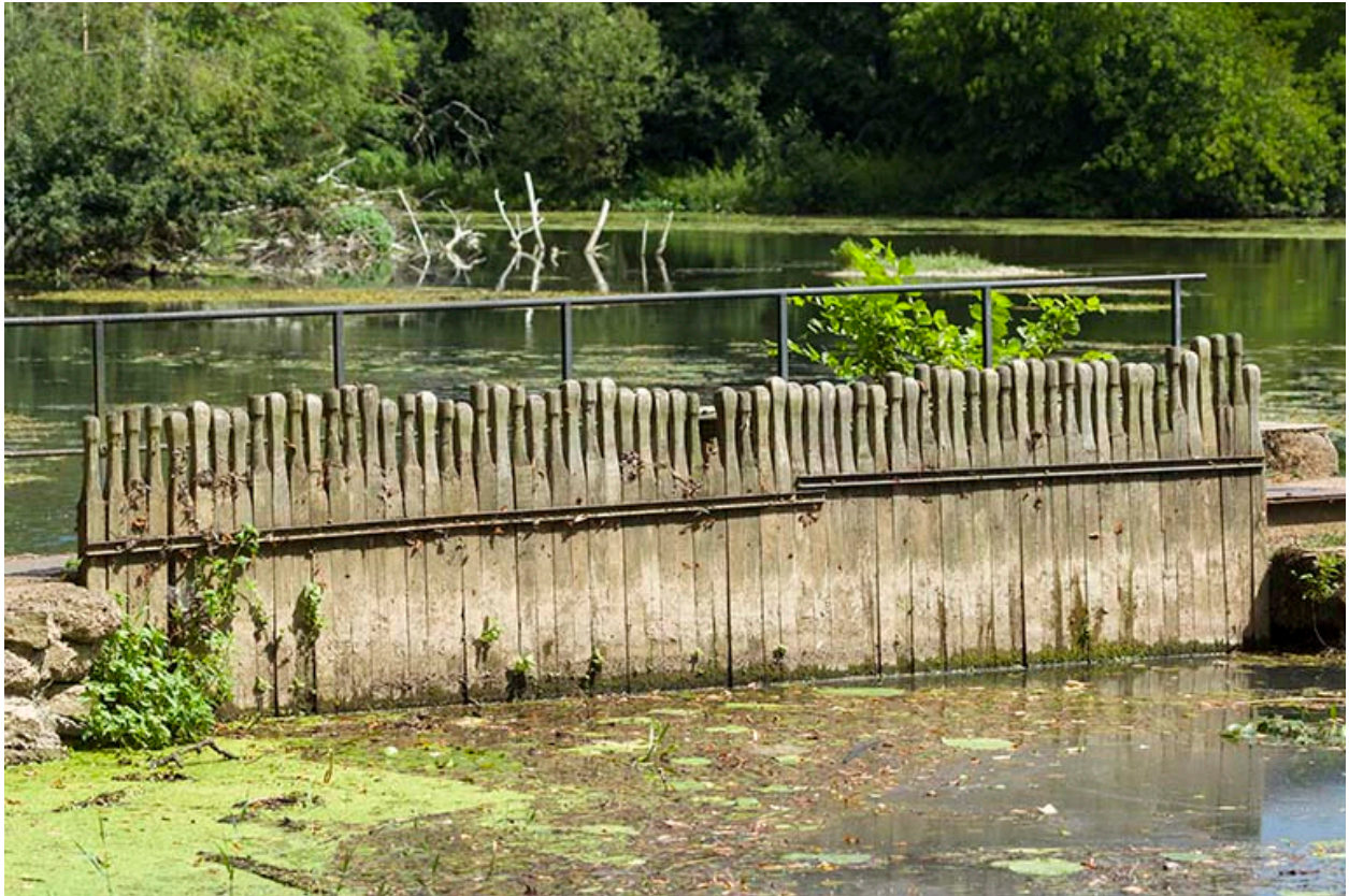
Aiguilles fermant l'ancien pertuis de navigation.
