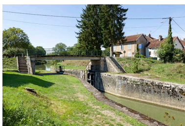
La porte de garde. Phot. Sonia Dourlot IVR43_20167001829NUC2A
