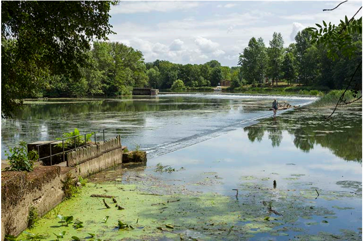
Ancien barrage usinier et la Saône.
