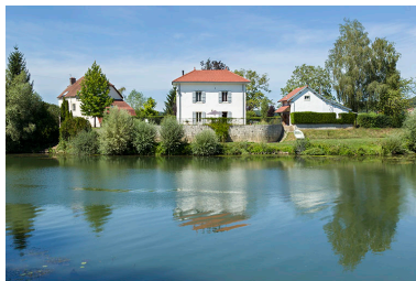
Embarcadère de l'ancien bac de Ray-sur-Saône. Phot. Sonia Dourlot IVR43_20167000247NUC2A
