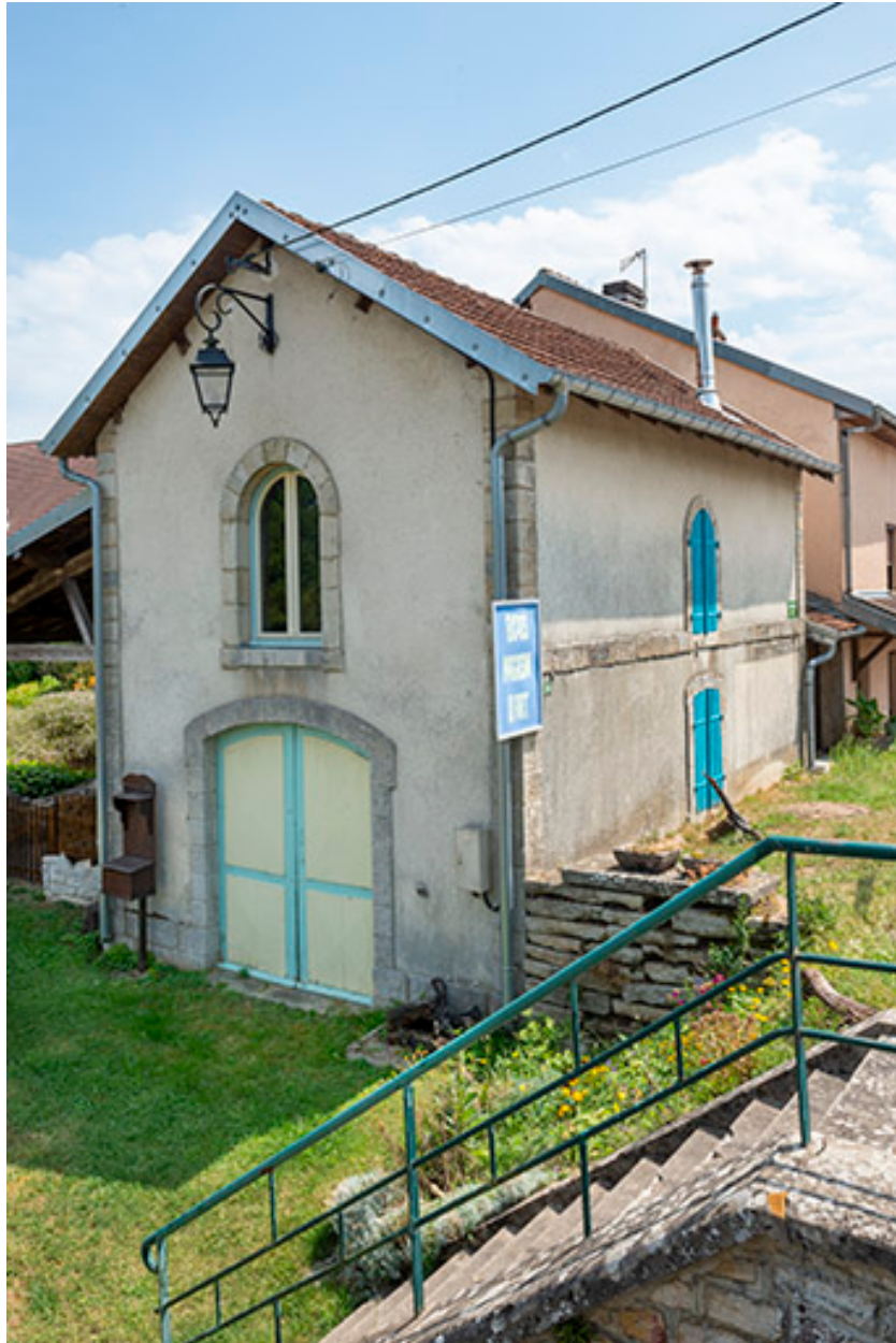
Magasin servant à la maintenance du pont-tournant.
