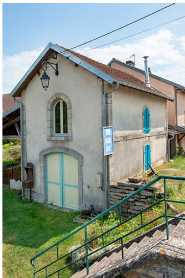
Magasin servant à la maintenance du pont-tournant. Phot. Jérôme Mongreville IVR43_20207000222NUC4A
