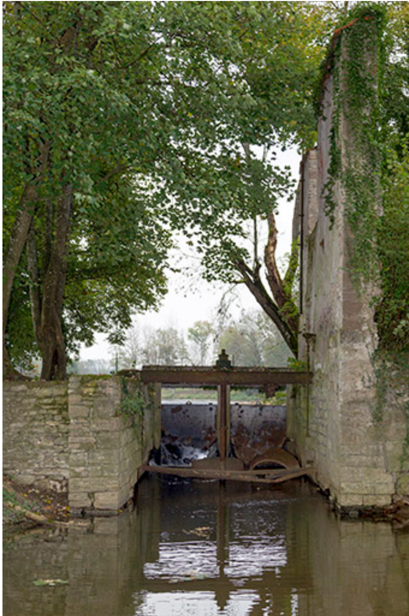
L'ancien canal de dérivation du moulin.
