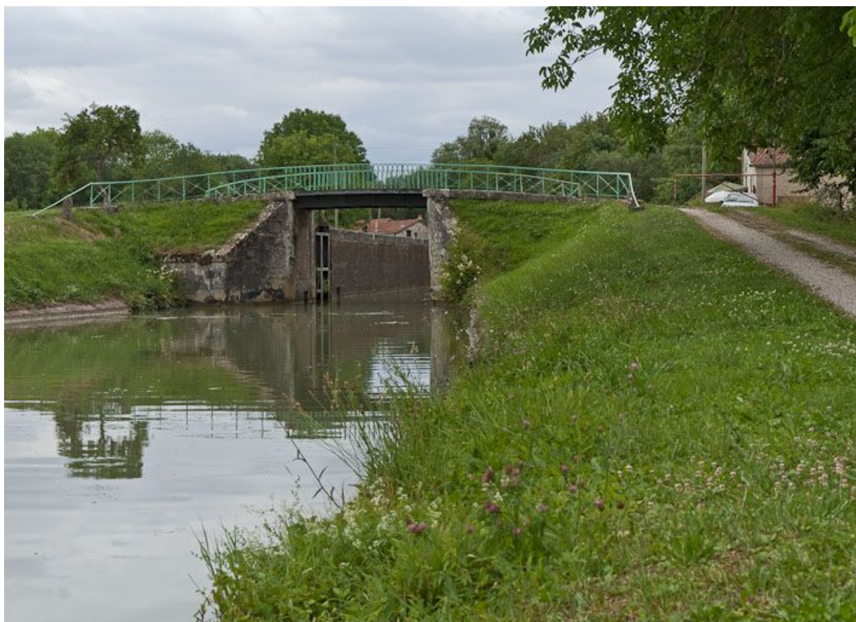
Vue du pont depuis l'aval.
