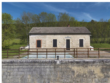
Site d'écluse : maison éclusière vue de face. Phot. Thierry Kuntz IVR26_20122102473NUC4A
