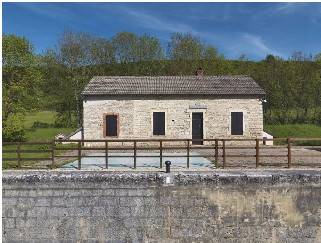
Site d'écluse : maison éclusière vue de face.
