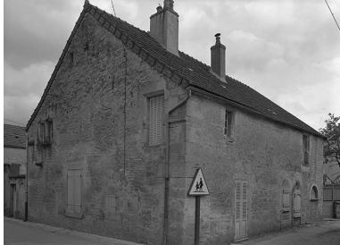
Mur-pignon et façade latérale. Phot. Michel Thierry IVR26_19748901173V
