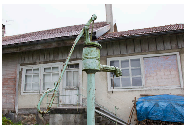
Exemple de pompe de Victorin Renaud à Charquemont (ferme d'Aster Frésard, 9 Grande Rue). Phot. Yves Sancey IVR43_20132503010NUC2A
