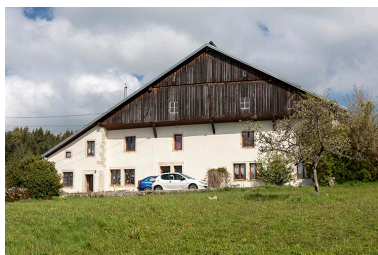
Façade antérieure. Phot. Sonia Dourlot IVR43_20192500390NUC4A
