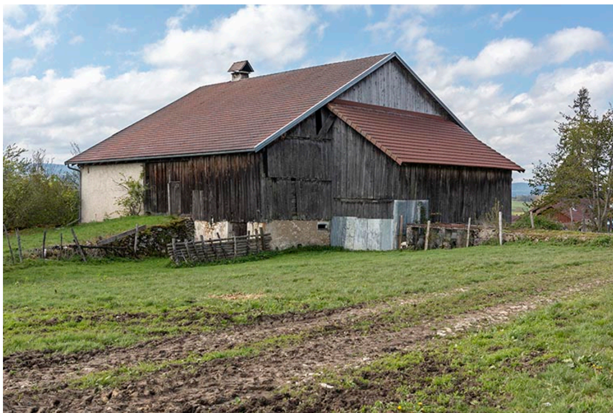
Façades postérieure et latérale droite.
