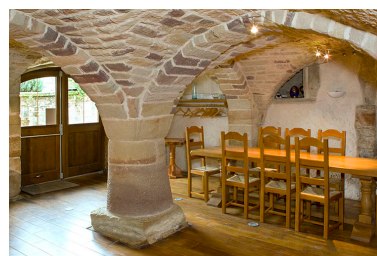
Vue sur le pilier central de la cave. Phot. Sonia Dourlot IVR43_20157000522NUC2A
