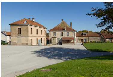
Façades sud et est de l'école. Phot. Sonia Dourlot IVR43_20157000520NUC2A
