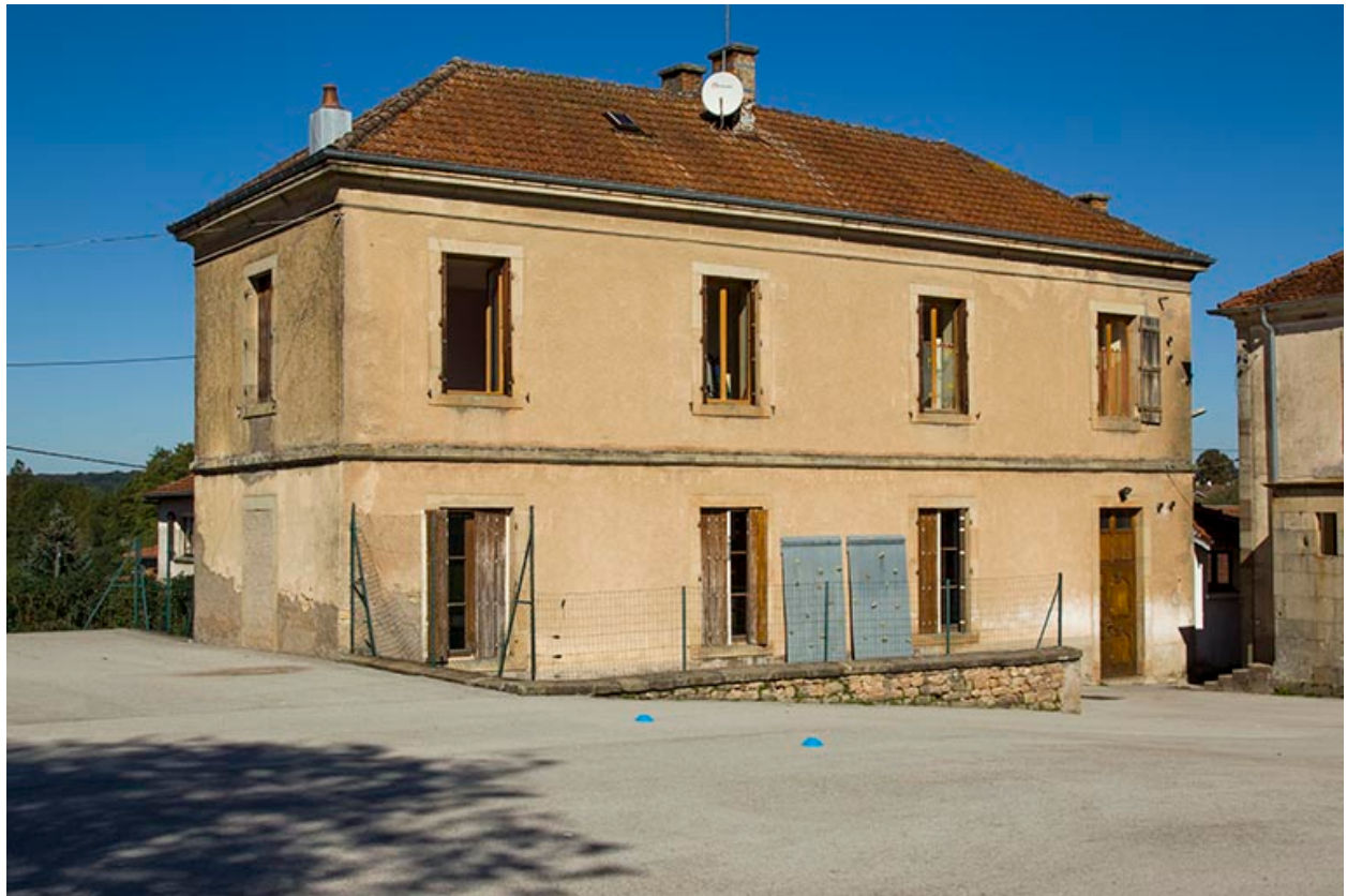
Façade postérieure de l'ancienne école enfantine.
