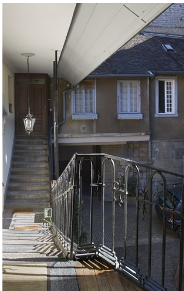
Vue de l'escalier à cage ouverte de profil. Phot. Yves Sancey IVR43_20072500311NUCA
