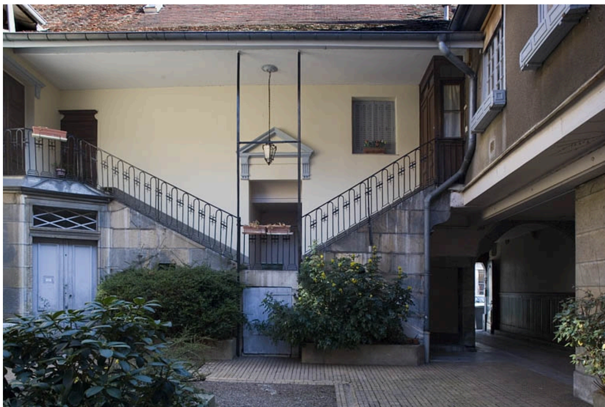
Vue d'ensemble de l'escalier à cage ouverte, de face.
