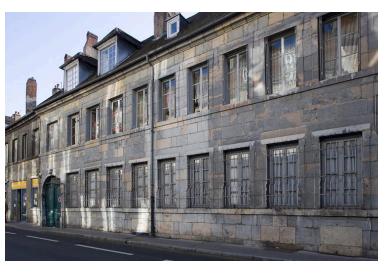
Vue d'ensemble depuis la rue, de trois quarts droit. Phot. Yves Sancey IVR43_20072500313NUCA
