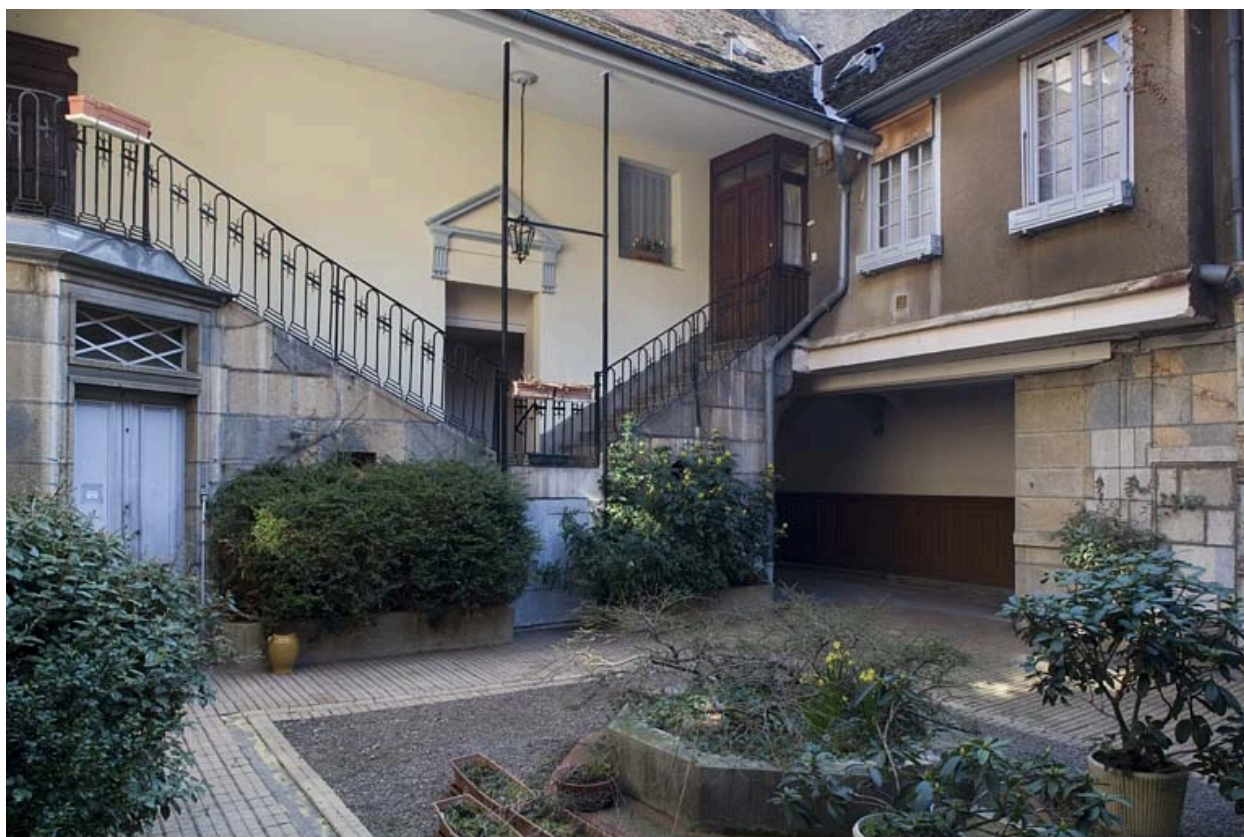
Vue d'ensemble de l'escalier à cage ouverte, de trois quarts gauche.
