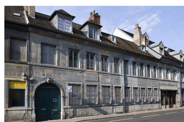
Vue d'ensemble depuis la rue de trois quarts gauche. Phot. Yves Sancey IVR43_20072500320NUCA
