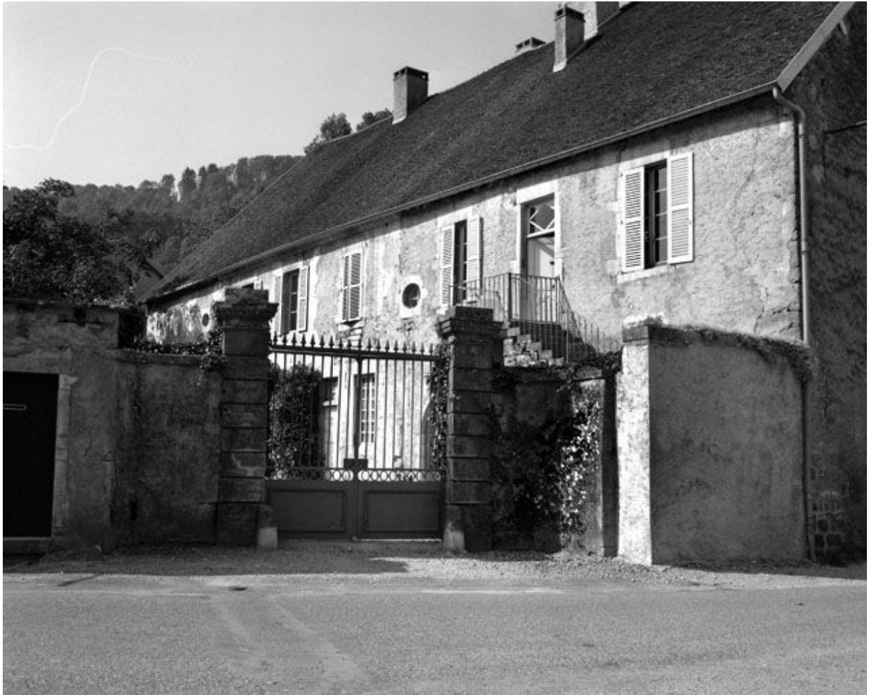
Maison de vigneron située 2 rue de la Liberté.
