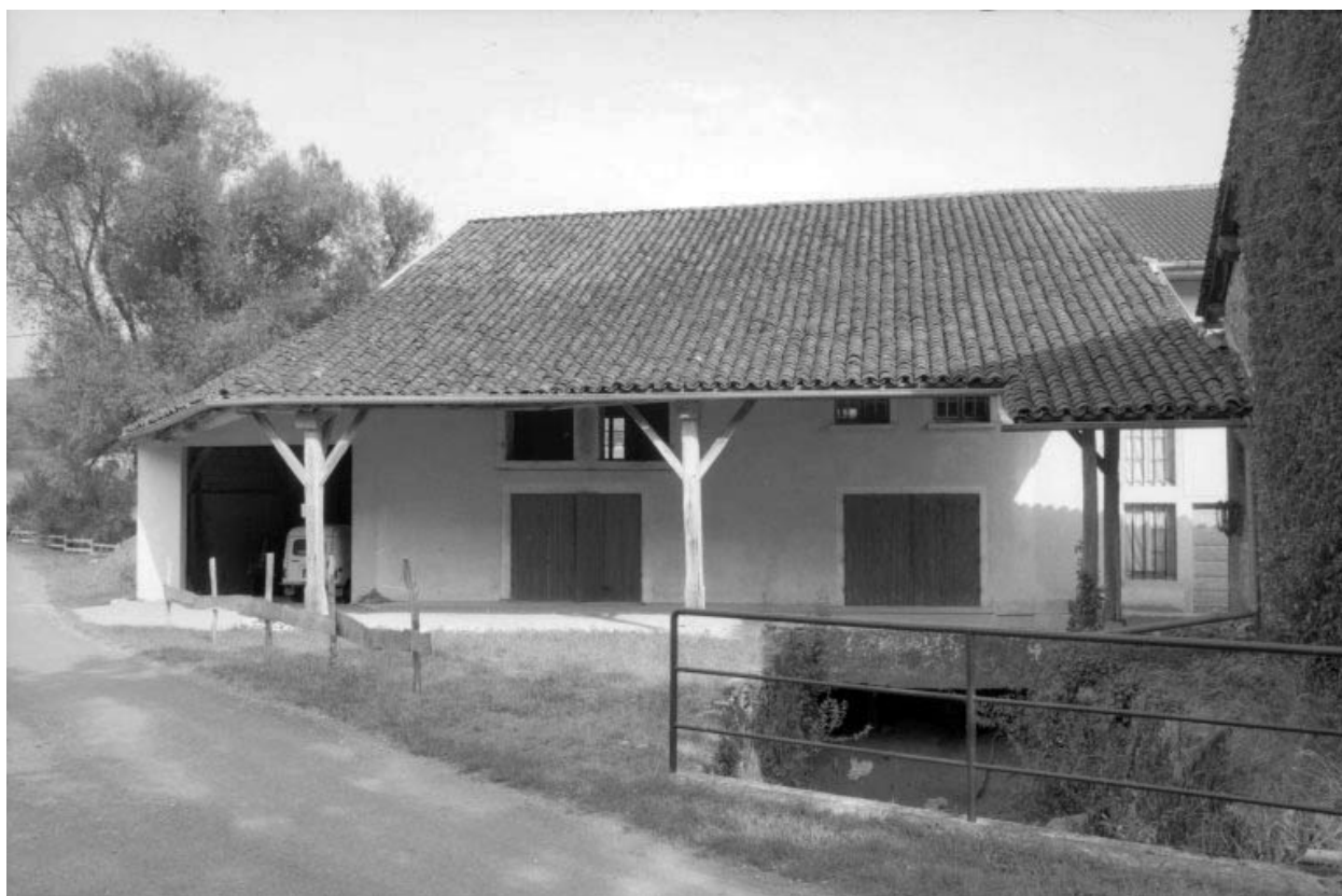
Canal d'amenée et auvent.
