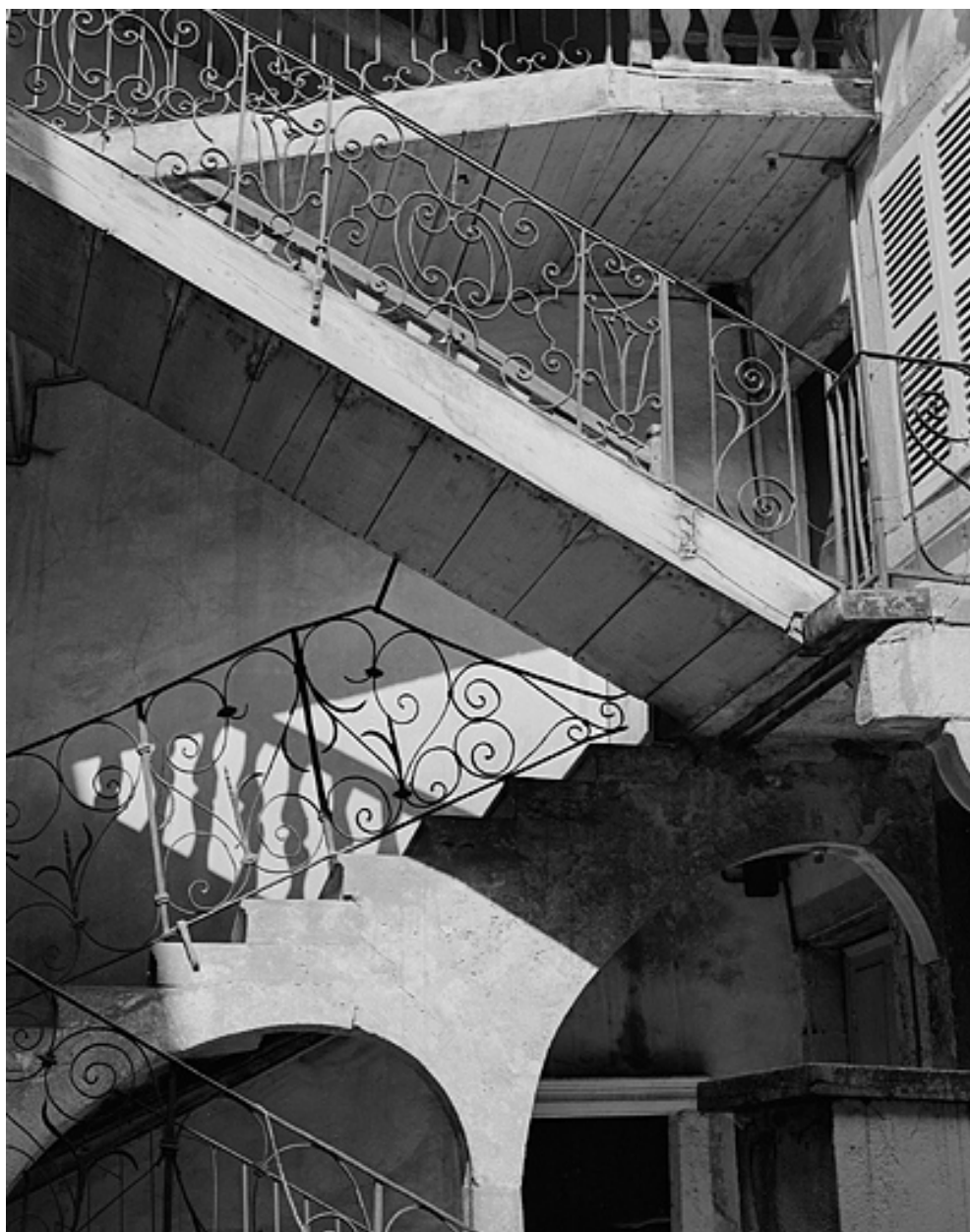
Escalier dans la cour, détail des rampes.
