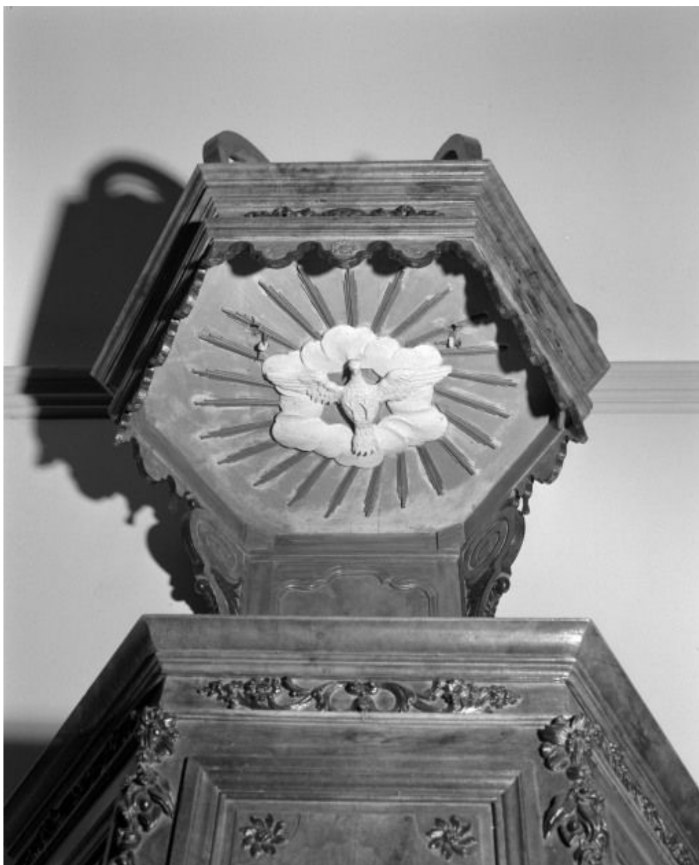
Plafond de l'abat-voix.
