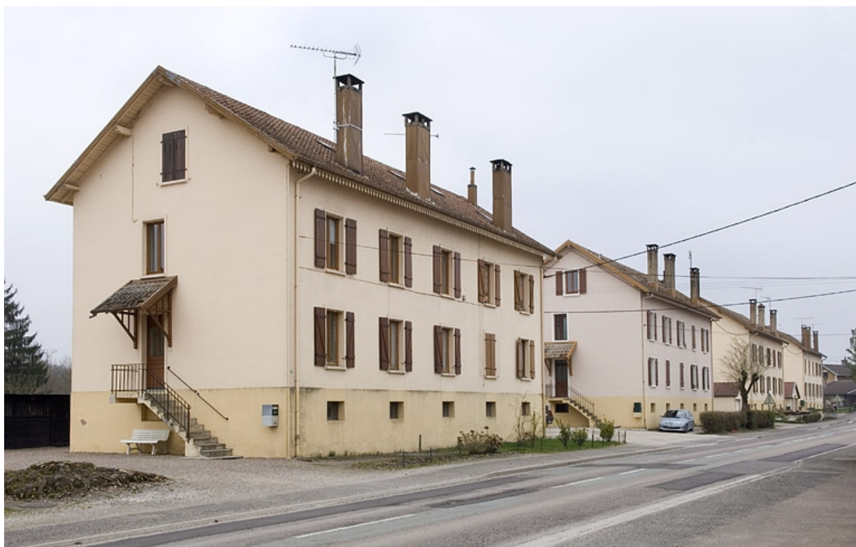
La cité ouvrière vue depuis la rue.
