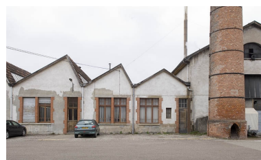
Façade est : bureaux, cheminée et chaufferie. Phot. Jérôme Mongreville IVR43_20097000638NUC2A
