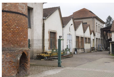
Pignons des sheds de l'atelier. Phot. Jérôme Mongreville IVR43_20097000633NUC2A
