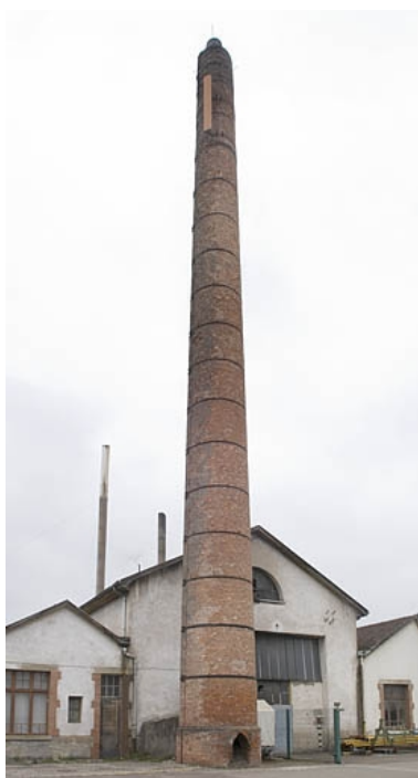
La cheminée et la chaufferie. Phot. Jérôme Mongreville IVR43_20097000637NUC2A
