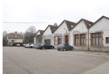
Les bureaux. Phot. Jérôme Mongreville IVR43_20097000634NUC2A
