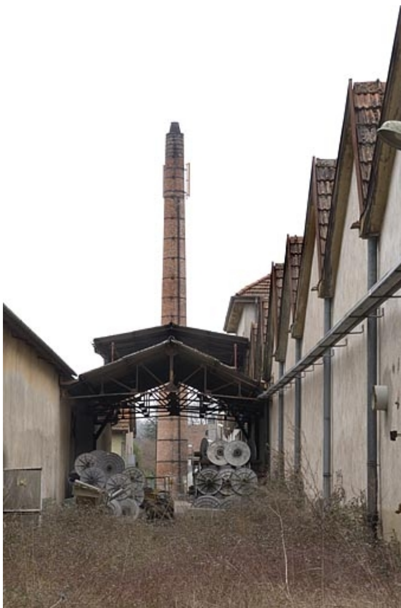
La cheminée vue depuis le nord.
