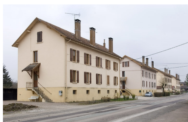
La cité ouvrière vue depuis la rue. Phot. Jérôme Mongreville IVR43_20097000627NUC2A
