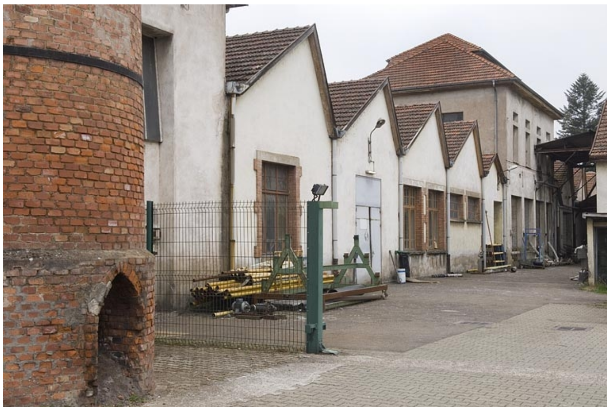
Pignons des sheds de l'atelier.
