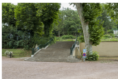
Escalier extérieur conduisant à la terrasse du casino. Phot. Pierre-Marie Barbe-Richaud IVR26_20195800436NUC4A
