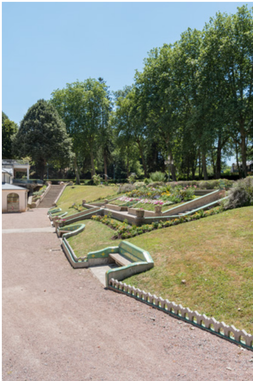
Escalier extérieur devant l'établissement thermal, vue d'ensemble depuis le nord.
