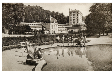
Grand bassin, état au début des années 1950. IVR26_20195800280NUC4A
