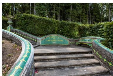
Escalier extérieur conduisant à la chapelle du parc, repos. Phot. Pierre-Marie Barbe-Richaud IVR26_20195800287NUC4A
