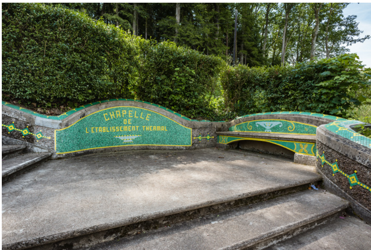
Escalier extérieur conduisant à la chapelle du parc, repos.
