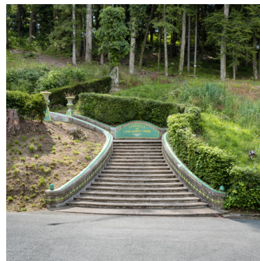
Escalier extérieur conduisant à la chapelle du parc. Phot. Pierre-Marie Barbe-Richaud IVR26_20195800285NUC2A
