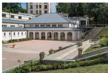
Escalier extérieur devant l'établissement thermal, vue d'ensemble depuis le parc. Phot. Pierre-Marie Barbe-Richaud IVR26_20195800412NUC4A
