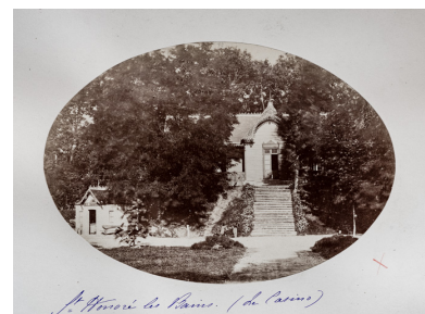
Bureau des Diligences, situé à côté de l'escalier du casino. Phot. Pierre-Marie Barbe-Richaud, Autr. auteur inconnu IVR26_20195800295NUC4A
