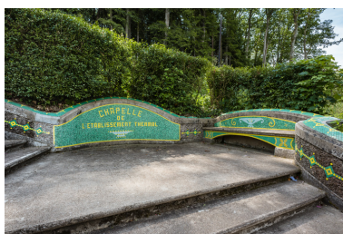
Escalier extérieur conduisant à la chapelle du parc, repos. Phot. Pierre-Marie Barbe-Richaud IVR26_20195800286NUC4A
