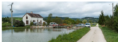
Vue du site d'écluse depuis l'amont. Phot. Pierre-Marie Barbe-Richaud IVR26_20112104041NUC4AQ
