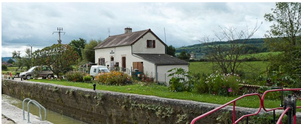
Vue d'ensemble du site d'écluse.
