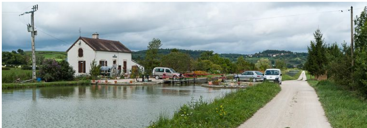
Vue du site d'écluse depuis l'amont.
