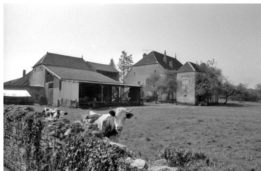
Demeure située rue Basse, vue depuis la rue des Baraques. Phot. Bernard Lardière IVR43_19817000572Z
