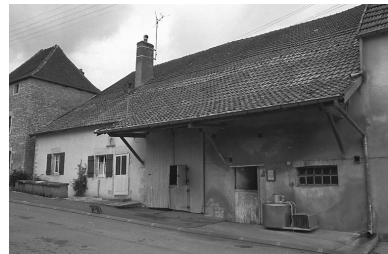
Ferme située rue Haute. Phot. Bernard Lardière IVR43_19817000583Z
