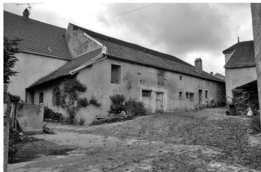
Ferme située rue Haute. Phot. Bernard Lardière IVR43_19817000584Z
