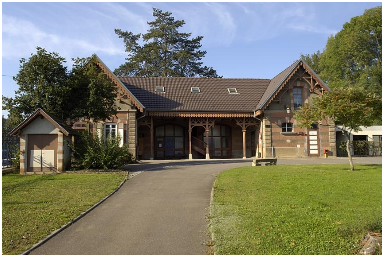
Façade nord de l'ancienne écurie (?).
