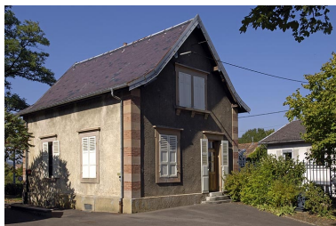
Conciergerie. Phot. Jérôme Mongreville IVR43_20057000538NUCA
