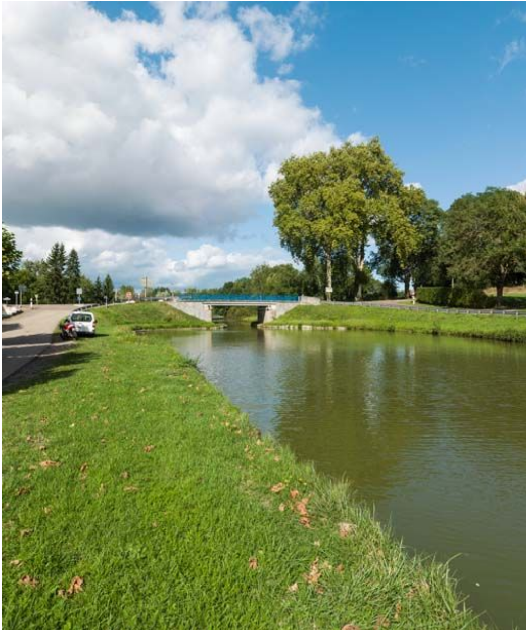
Vue d'ensemble du pont.
