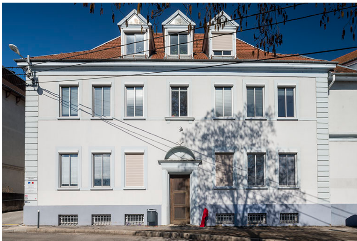
Façade antérieure des bureaux.
