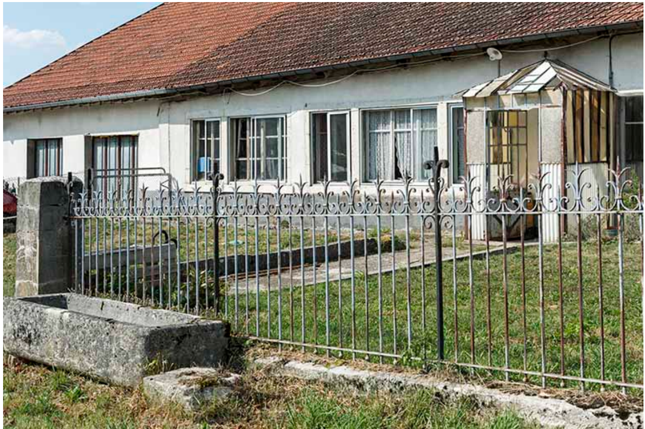
Fenêtres de l'atelier sur la façade antérieure.
