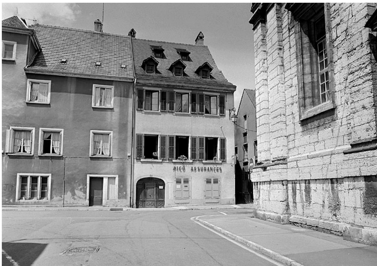
Façade principale sur la rue Saint-Martin.
