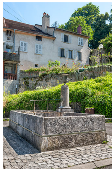
Vue depuis le sud. Phot. Jérôme Mongreville IVR43_20243900815NUC4A
