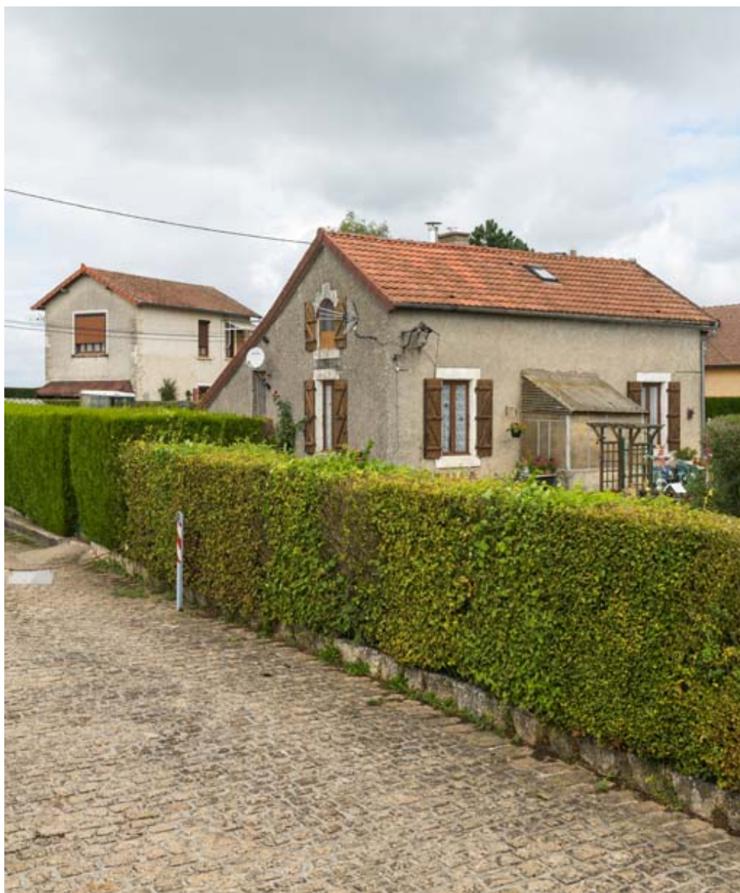
Vue rapprochée de la maison.
