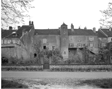
Façade sur jardin donnant sur l'Ognon. Phot. Yves Sancey IVR43_19857000029V
