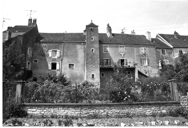
Façade sur jardin donnant sur l'Ognon. Phot. Bernard Lardière IVR43_19817000669Z
