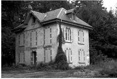
Vue d'ensemble du "Pavillon des chasseurs". Phot. Yves Sancey IVR43_19819000031X
