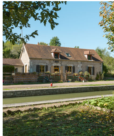
Vue de la maison éclusière.
