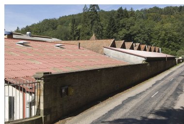
Toitures des ateliers le long de la route de Plombières. Phot. Jérôme Mongreville IVR43_20067000783NUCA
