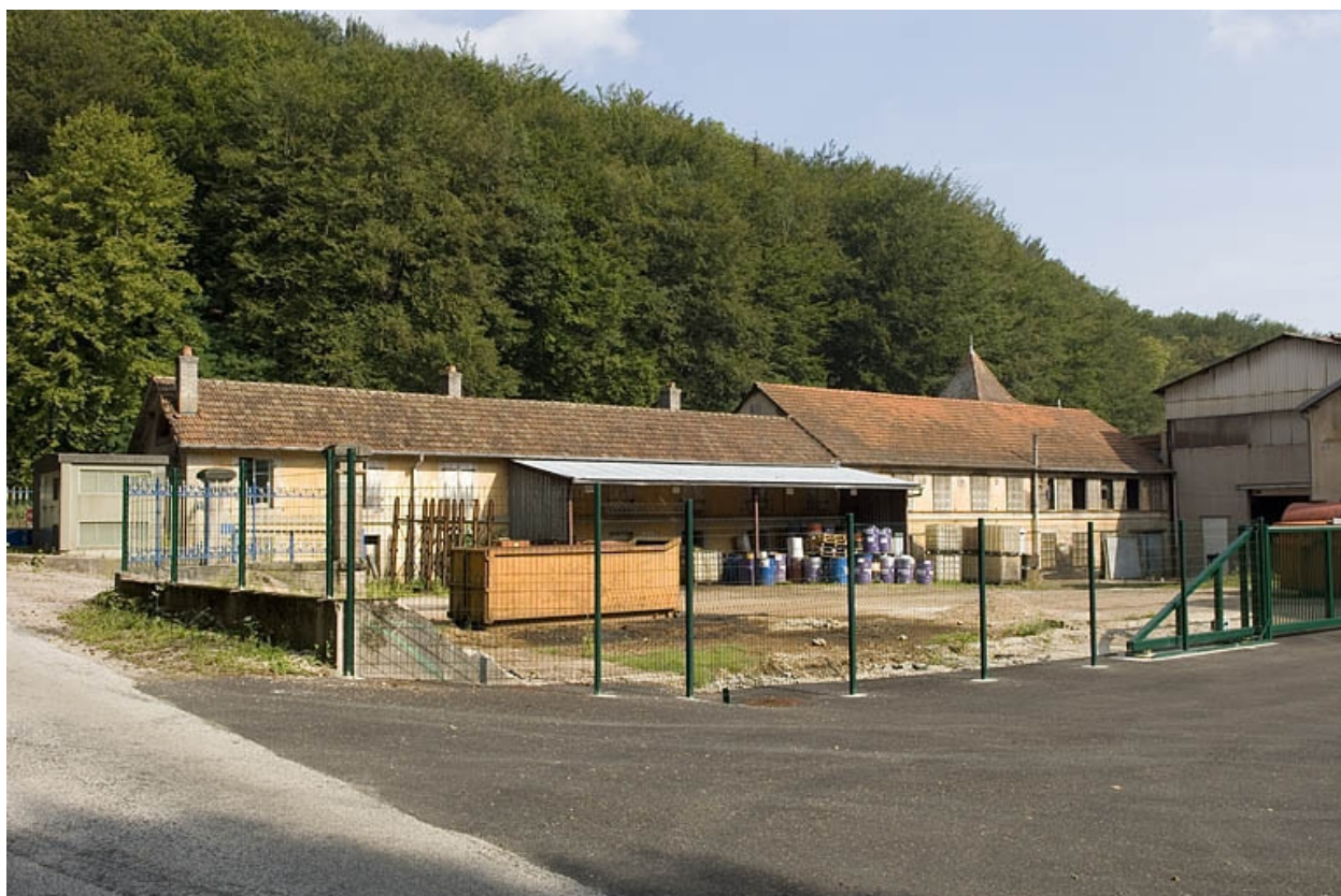
Bâtiments industriels depuis l'ouest.
