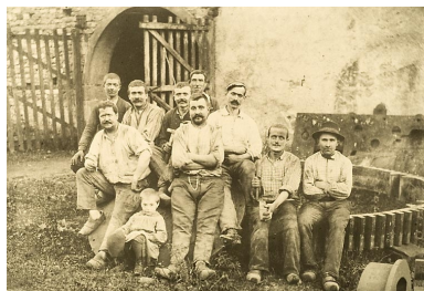
Ouvriers posant devant l'atelier de forge. Phot. Jérôme Mongreville IVR43_20077000080NUCA
