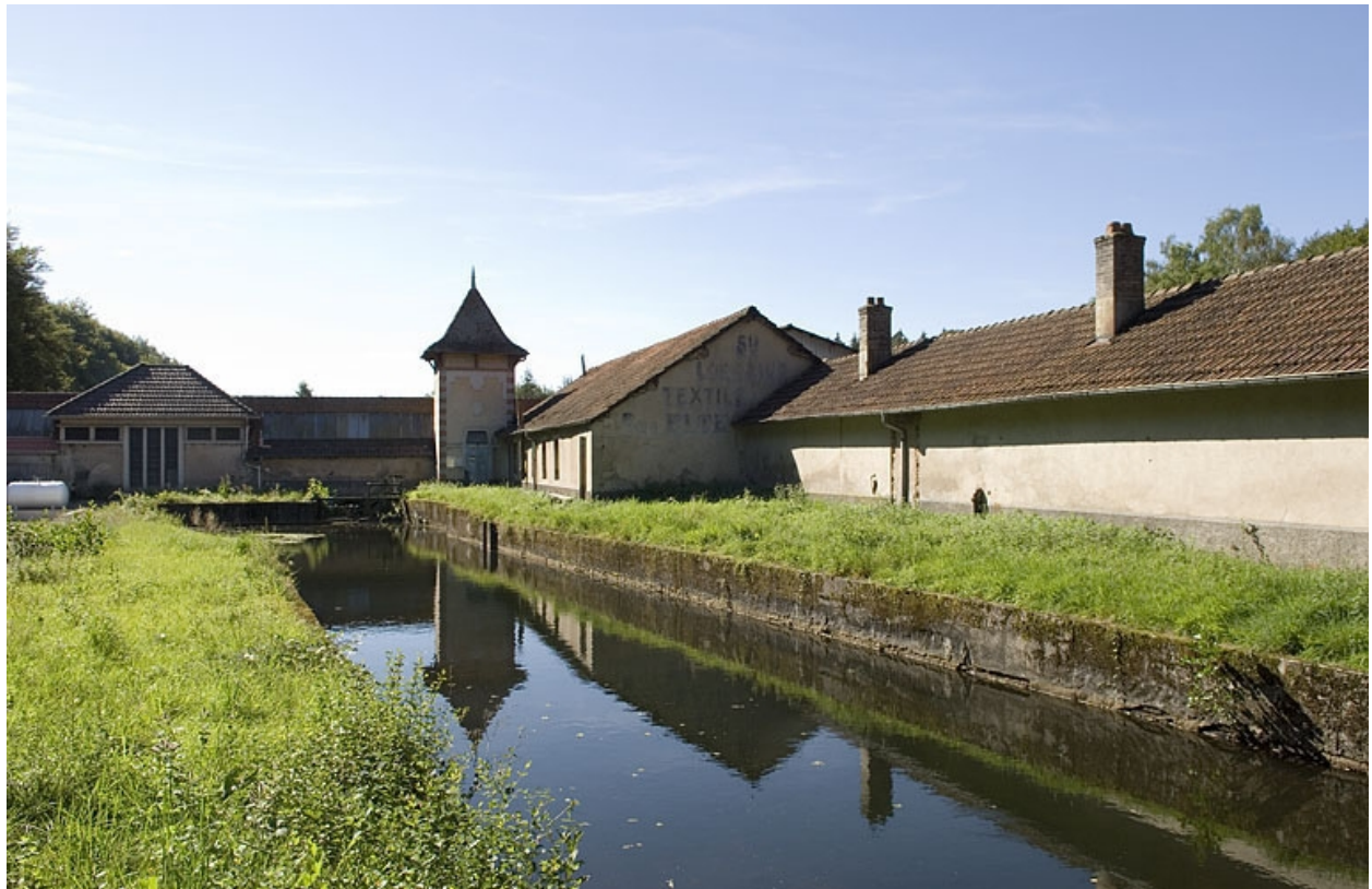
Ateliers et bief d'amenée.
