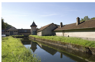
Ateliers et bief d'amenée. Phot. Jérôme Mongreville IVR43_20067000781NUCA
