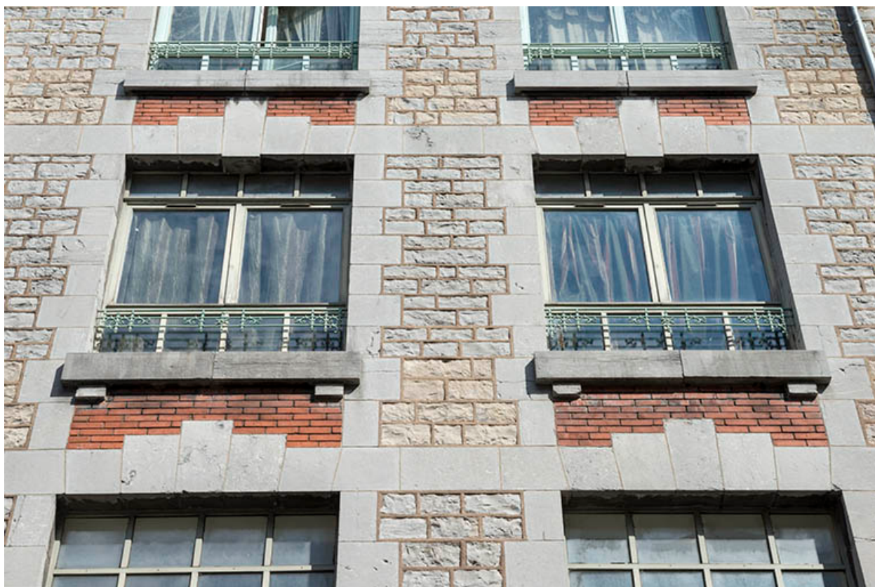
Détail de la façade.
