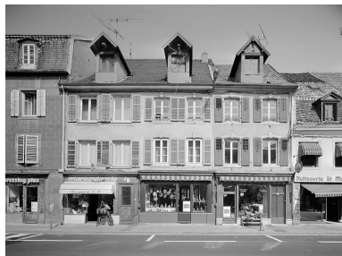
Façade sur rue. Au centre, demeure qui formait avec elle une maison double. Phot. Jérôme Mongreville IVR43_19872501259V
