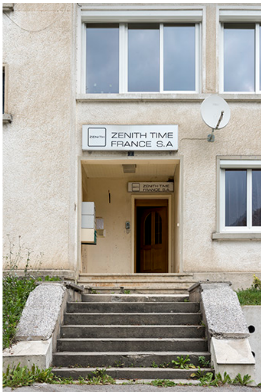
Façade antérieure : entrée de l'atelier de fabrication.
