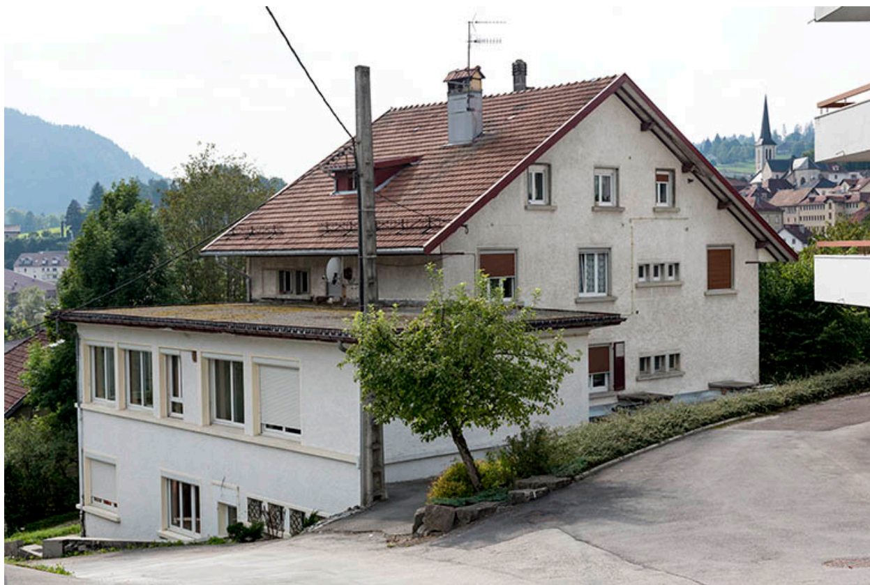
Façades postérieure et latérale droite.
