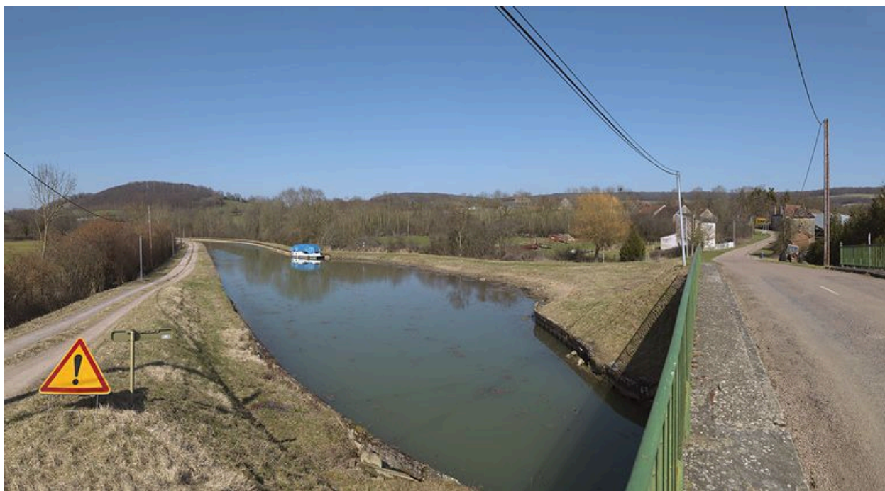
Vue d'ensemble du bassin de port.
