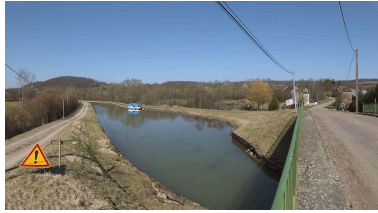
Vue d'ensemble du bassin de port. Phot. Thierry Kuntz IVR26_20122102638NUC4A
